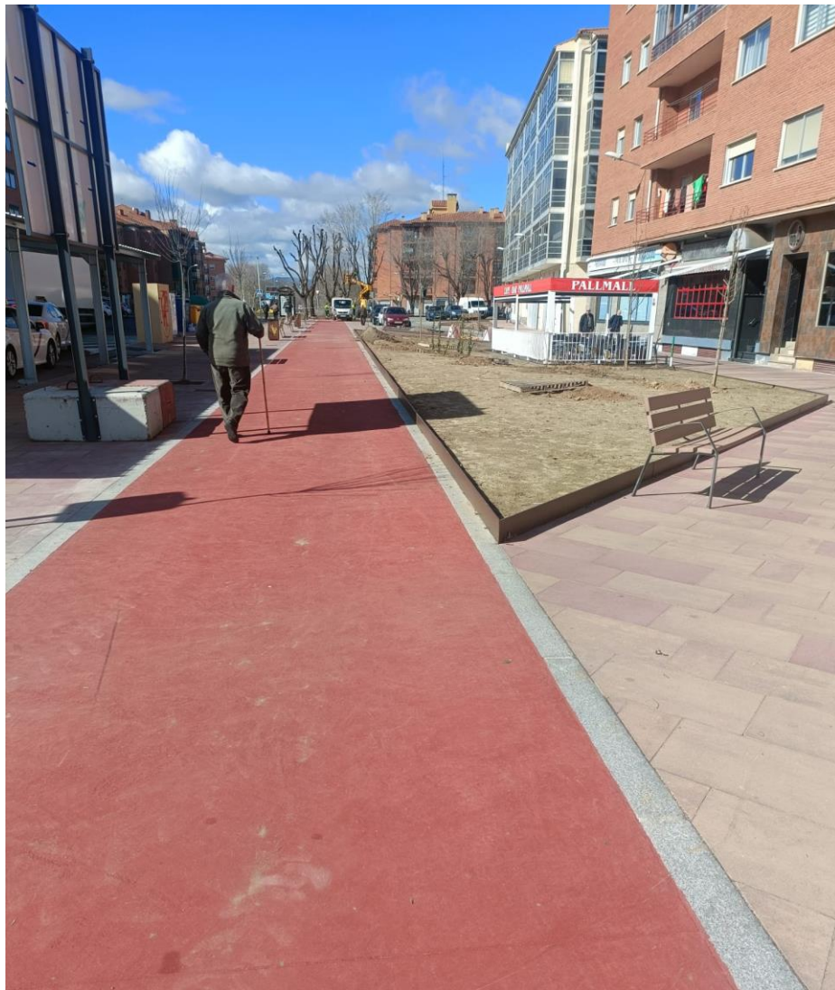
Foto 100: Rehabilitación accesible de la Avda. Juan Pablo II, Ávila. Se observa el itinerario peatonal de rojo, con una chapa que separa la vegetación, y ayuda a las personas con visibilidad reducida a desplazarse. FA.
