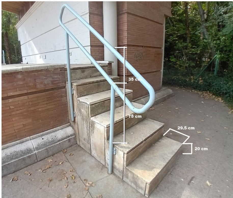
Foto 27: Escalera de acceso al templo de la Pérgola. Fotografía de la autora.
