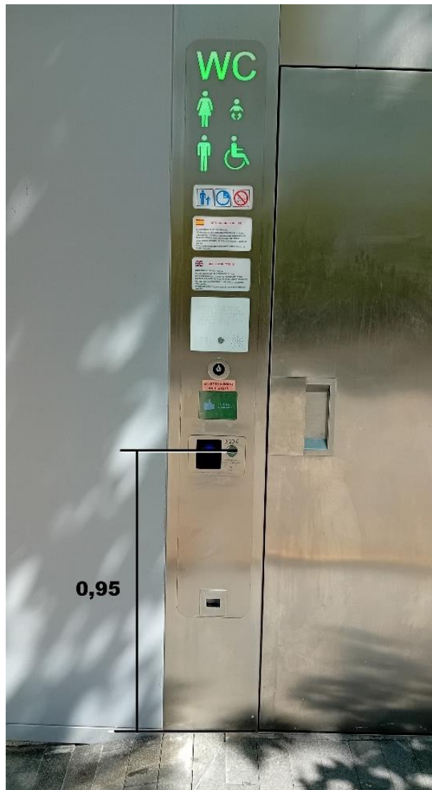
Foto 64: Altura de agarre de la puerta. Espacio higiénico a la salida de Campo Grande, Valladolid. Fotografía de la autora.
