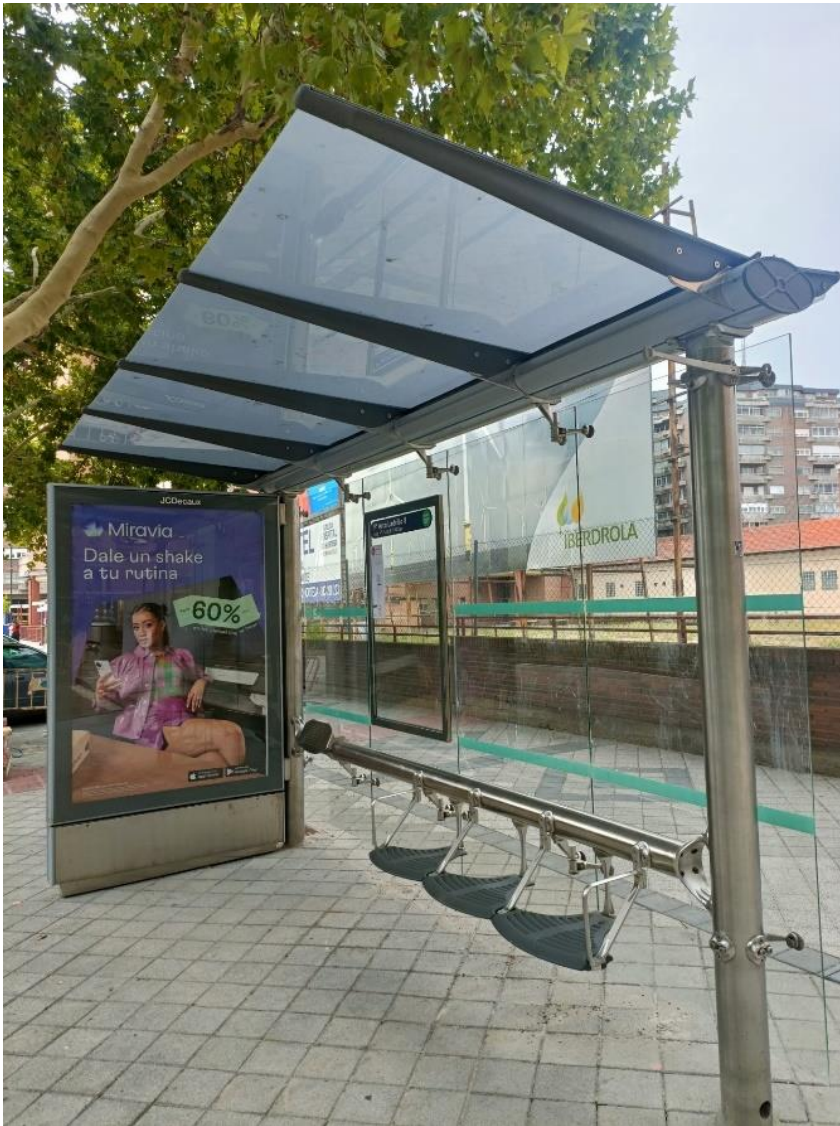
Foto 19: Parada de autobús en la calle Pº Arco de Ladrillo, cercana a Campo Grande. Valladolid. Fotografía de la autora.
