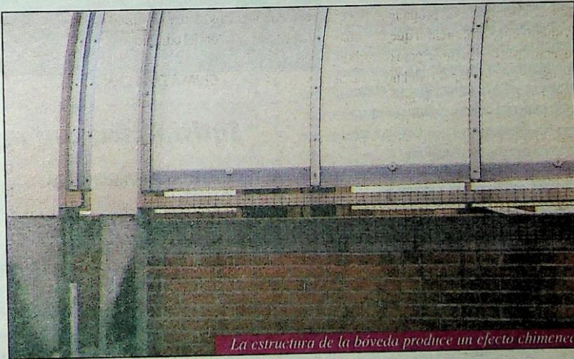
La estructura de la bóveda produce un efecto chimenea.
