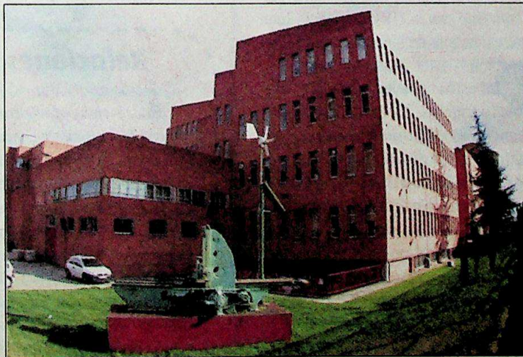
Edificio de la E.U. Politécnica
