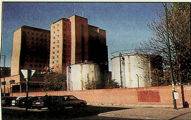
Depósitos donde se ubicará el nuevo edificio del IBGM Salvador Mata
