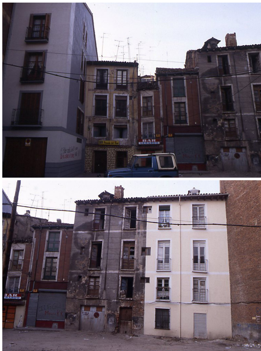
Figura 65. Valladolid, Centro Histórico. El abandono de la edificación como paso previo a su renovación posterior. Calle Sandoval antes de la renovación.
