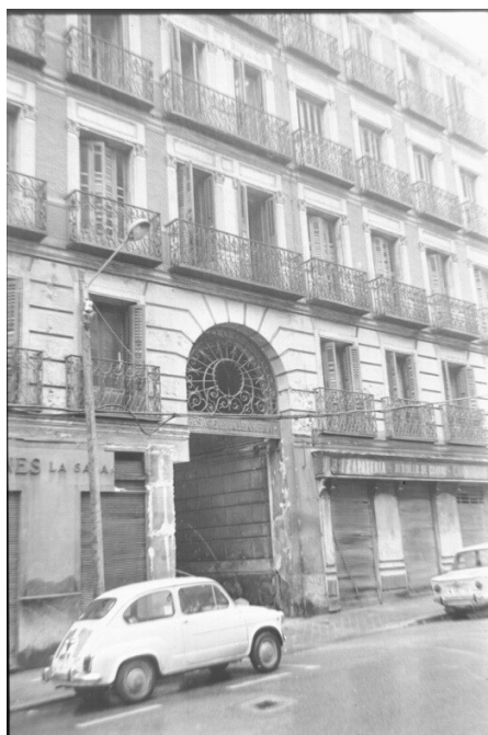
Figura 19. Pasaje de la Alhambra antes de la demolición
