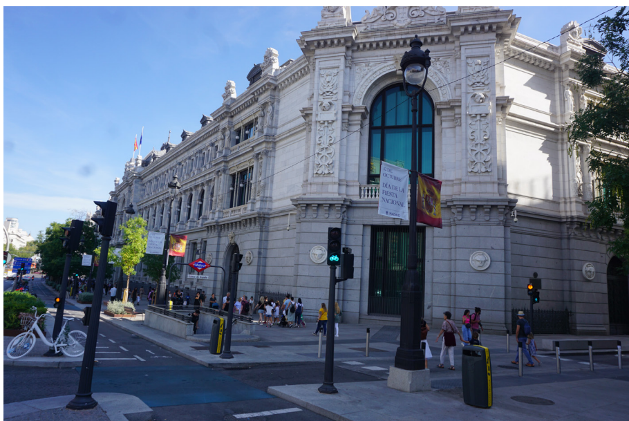
Figura 22. Edificio Lorite-Banco España. Antes y después de su demolición.
