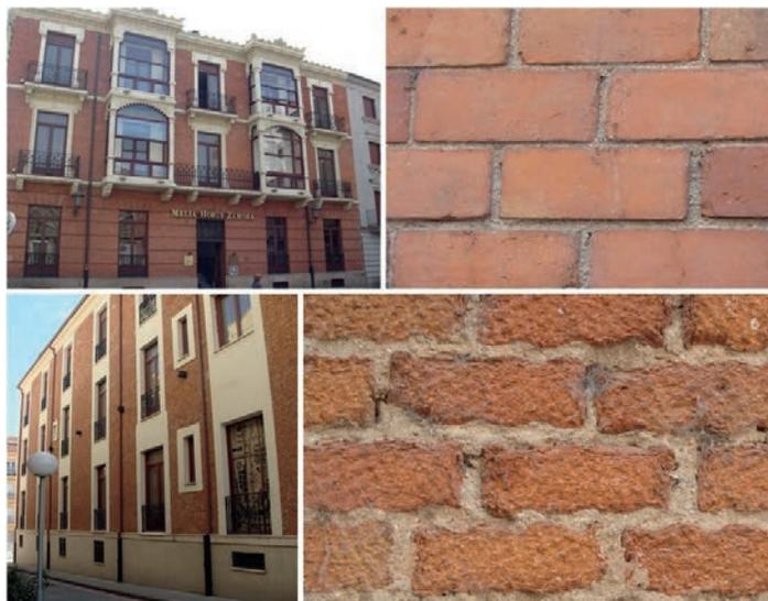
*Fig. 13. Vistas generales de las fachadas de Casa Gabino Bobo. Sup. Fachada principal y detalle del aparejo con ladrillos prensados. Inf. Fachada secundaria y detalle del aparejo con ladrillos ordinarios acanalados. Fotografías de los autores (2022).*
