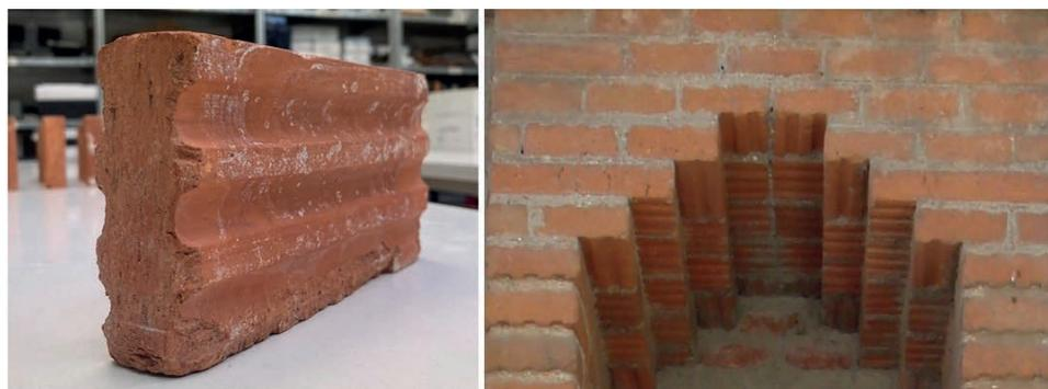
Figura 12. Izq. Ladrillo extrusionado de la Tejera San Antonio con acanaladuras en las tablas. Dcha. Detalle del arco de una ventana perteneciente al Cuartel Viriato (2022). Fotografías de los autores.
