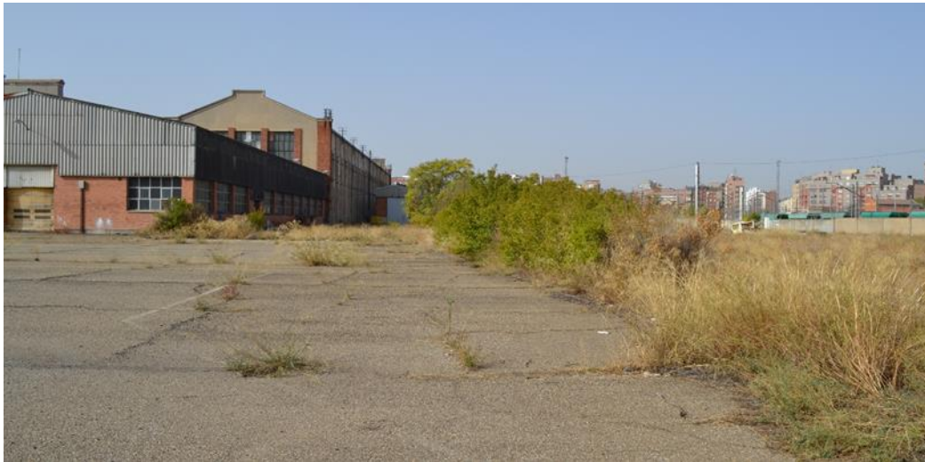
Fotografía propia donde se muestra el crecimiento descontrolado de la vegetación.
