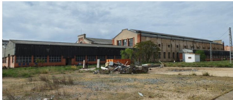
Estado actual de las naves de montaje 1 y 2
