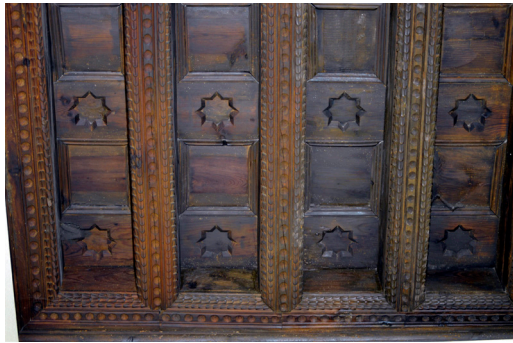
Figura 8. Detalle del forjado con menado de estrellas de 8 puntas. Sala próxima al ángulo suroccidental del patio principal. Fuente: Joaquín García Nistal.
