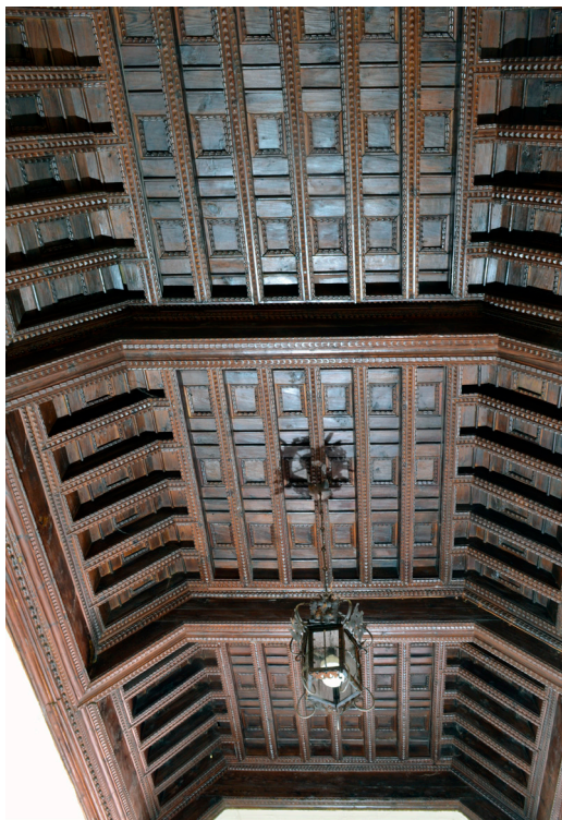
Figura 15. Forjado con jabalcones situado en la sala del ángulo noroccidental del patio principal. Fuente: Joaquín García Nistal.
