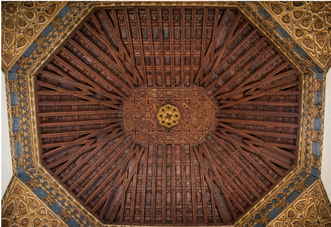
Figura 3. Armadura de cubierta del presbiterio de la antigua iglesia de Ntra. Sra. del Rosario, actualmente en la sala XVI del Museo Nacional de Escultura de Valladolid. Fuente: Ramón Muñoz López.
