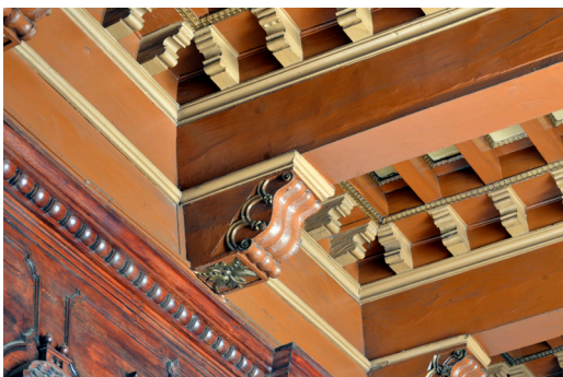
Figura 13. Detalle de los integrantes del alfarje del zaguán. Palacio Real de Valladolid. Fuente: Joaquín García Nistal.
