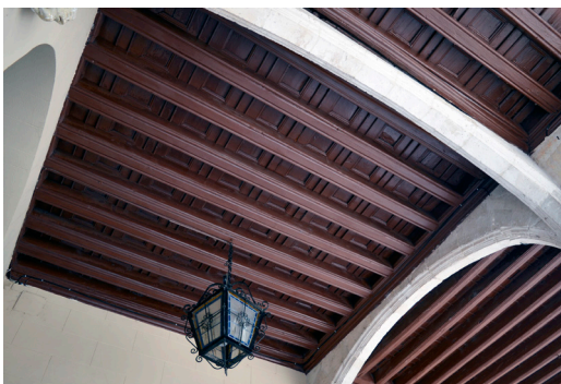
Figura 6. Solución de forjados en el encuentro entre crujiás. Piso bajo del patio principal del Palacio Real de Valladolid. Fuente: Joaquín García Nistal.
