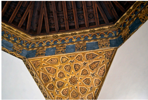
Figura 4. Detalle del arrocabe, pechina y zona inferior de los paños de la armadura de la antigua iglesia de Nuestra Señora del Rosario. Fuente: Joaquín García Nistal.
