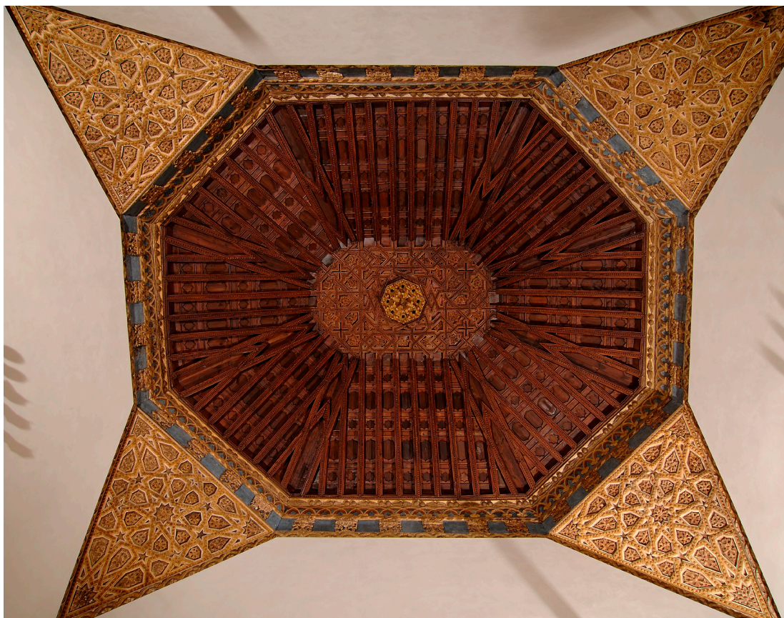
Figura 1. Armadura de limas moamares de la antigua iglesia de Nuestra Sra. del Rosario (Palacio Real de Valladolid), ca. 1535. Fuente: © Museo Nacional de Escultura. Valladolid. fotografía de Javier Muñoz y Paz Pastor. CE1922.
