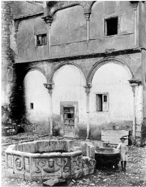
Figura 4. Fuente y ruinas del patio del Palacio de Francisco de los Cobos, Úbeda (Jaén). Fuente: Romero de Torres, 1913.
