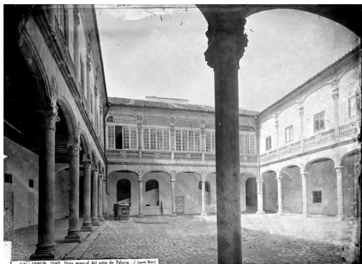
Figura 7. Patio de la Reina del Palacio Real de Valladolid, fot. De J. Laurent (1890 ca.)
