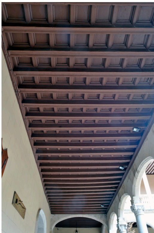
Figuras 5 y 7. Forjado de piso de la crujía septentrional del piso bajo del patio principal (izda.) y forjado de bovedillas de yeso de las galerías del piso noble (dcha.) Palacio Real de Valladolid. Fuente: Joaquín García Nistal.
