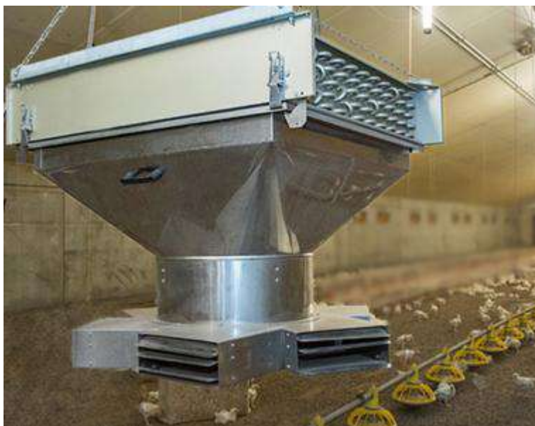
Figura 8. Difusor/calentador similar a los que se instalarán en la nave. Fuente: Roxell
