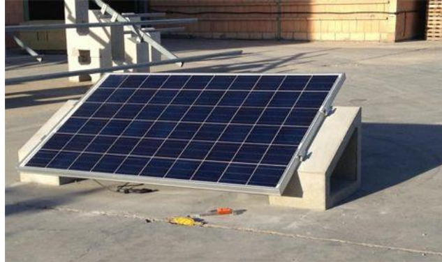
Figura 2. Sistema de montaje lastrado Fuente: Grupo labore
