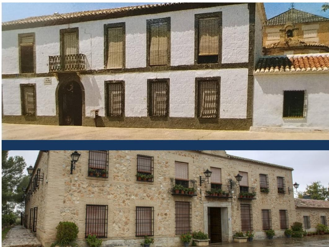
*Fig. 5. La parte superior muestra la fachada del Santuario de la Virgen de las Cruces en su estado original. En la parte inferior, tal y como se encuentra en la actualidad, con el revoco eliminado y presentando problemas de humedad en el zócalo. En la parte derecha de la imagen, la vivienda del santero, con el muro también desprovisto de la protección.*
