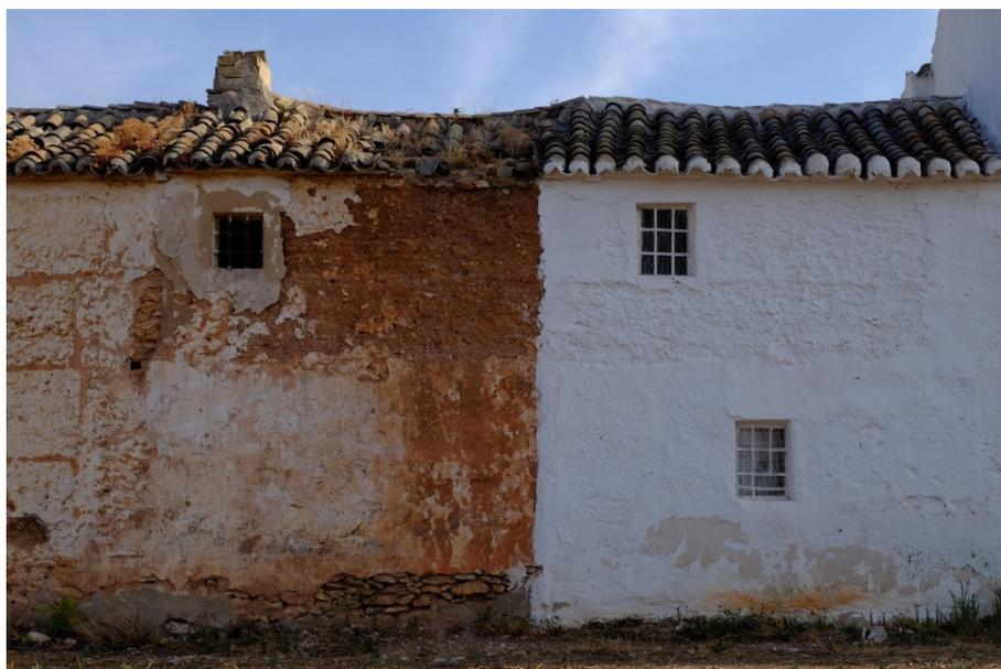
*Fig. 2. Se observa perfectamente como la parte izquierda, que ha comenzado a perder su capa de protección al no ser renovada, se encuentra muy deteriorada, frente a la parte derecha, que al conservarla se encuentra en muy buen estado.*
