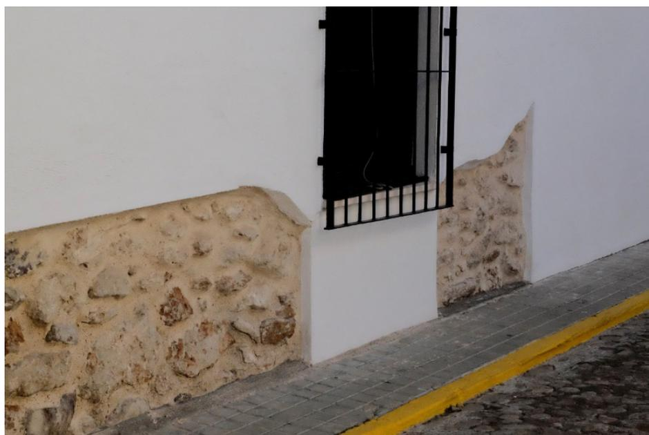
Fig. 4. En multitud de ejemplos de arquitectura tradicional de Almagro es posible observar como se pican los revocos para dejar la piedra vista (en este caso la mampostería de los cimientos), ocasionando no pocos problemas a la fábrica histórica.
