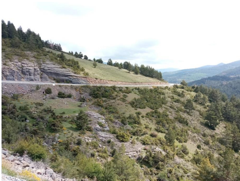
Figura 37. Imagen de una superficie donde se realizó un desbroce mecanizado en el año 2018 en la parte superior de la carretera. Elaboración propia.
