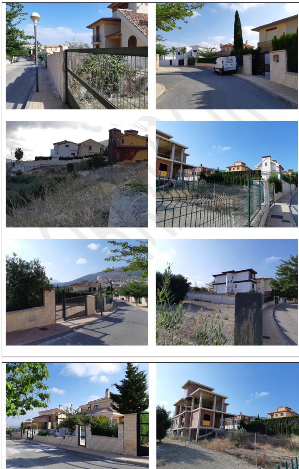
Fotografías 7 a 14.- Diferentes vistas de algunas de las construcciones sitas en las parcelas afectadas por la zona Suroeste de la vía pecuaria "Cañada Real Llanos de Arón", coincidente con la parte Noreste de la urbanización "Ciudad Jardín"
