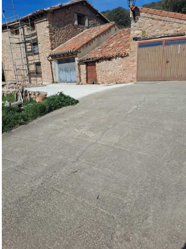
Figura 32: Ubicación del tercer equipo de bombeo de apoyo del anillo principal
