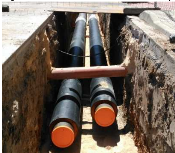
Figura 46: Tuberías de una red de calor en la zanja
