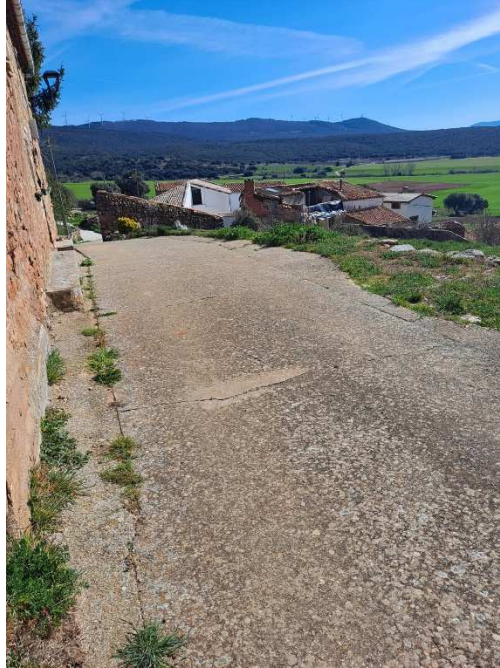
Figura 31: Ubicación del segundo equipo de bombeo de apoyo del anillo principal
