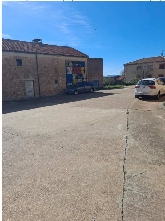
Figura 30: Ubicación del primer equipo de bombeo de apoyo del anillo principal
