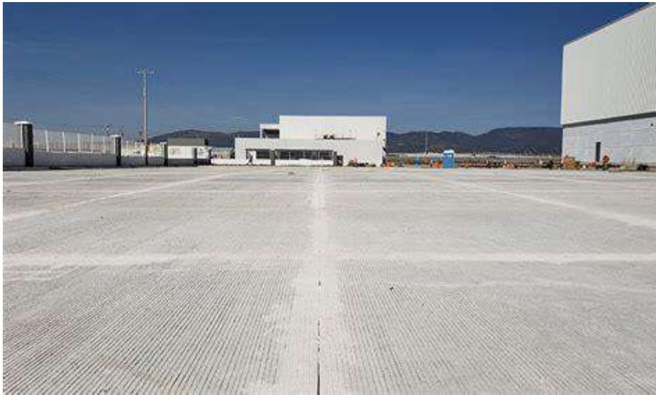
Foto: ejemplo pavimentación de hormigón
