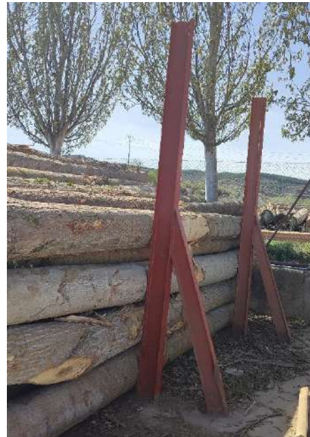
Foto: Pilote troncos Fuente: propia
