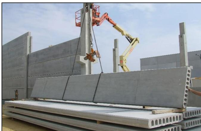
Imagen 10. Colocación de paneles alveolares. (Fuente: [prefabricadoseguro.com](http://prefabricadoseguro.com))
