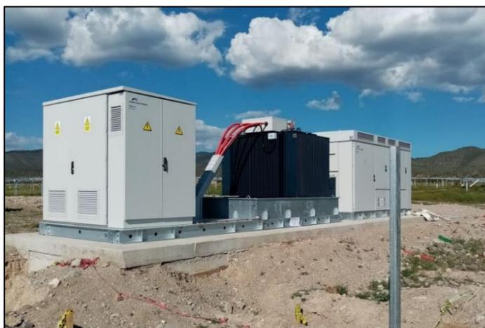
Imagen 1. Cimentación en centro de transformación. (Fuente: Laise.com)
