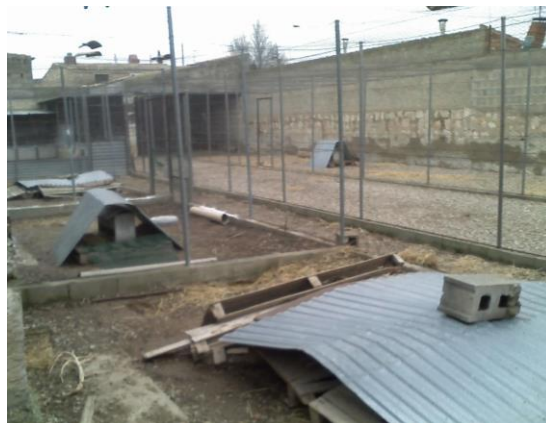
Imagen 4. Instalaciones cría conejo
