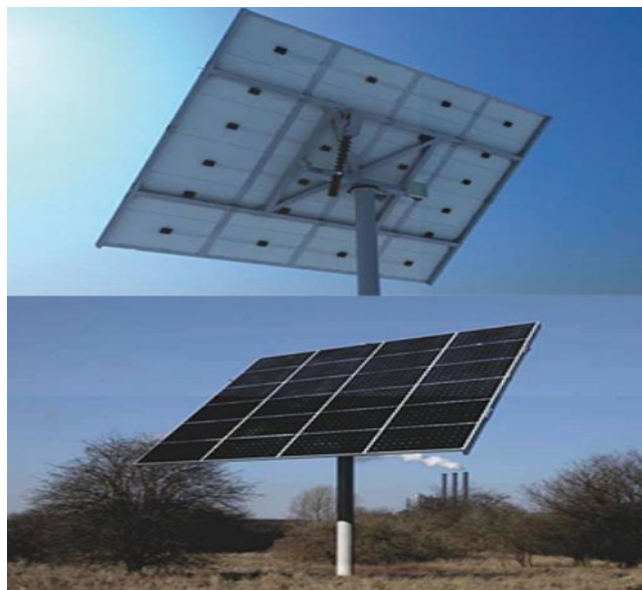
Figura 3: estructura soporte con seguimiento en dos ejes.
