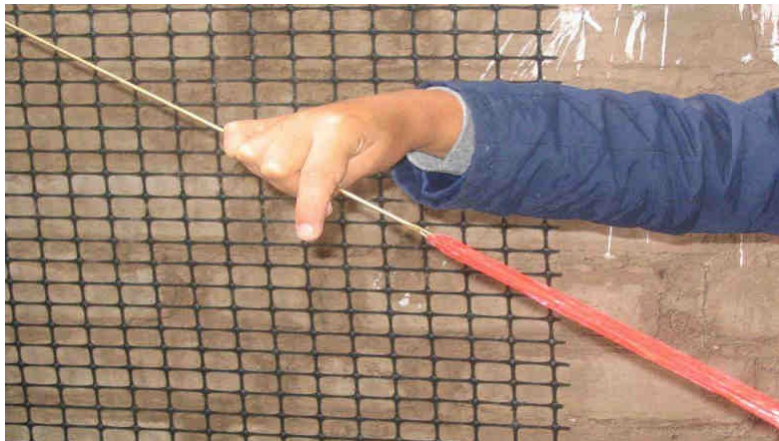
Figura 2. Refuerzo de una pared de una vivienda con geomallas.
