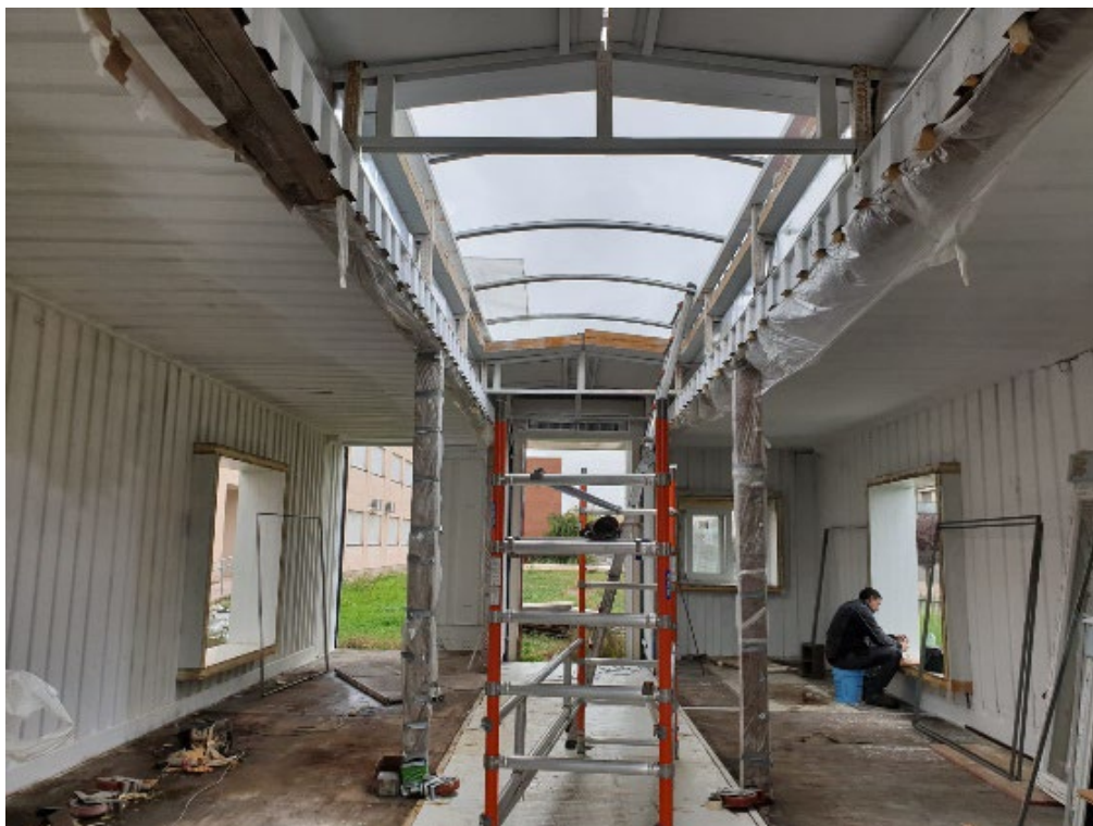
Figura 2. Estado de las obras del aula de Emprendimiento en el mes de octubre de 2023 donde se puede apreciar la incorporación de las ventanas grandes con vistas, el techo con ventana y la abundante luz natural solicitadas por los estudiantes de secundaria.
