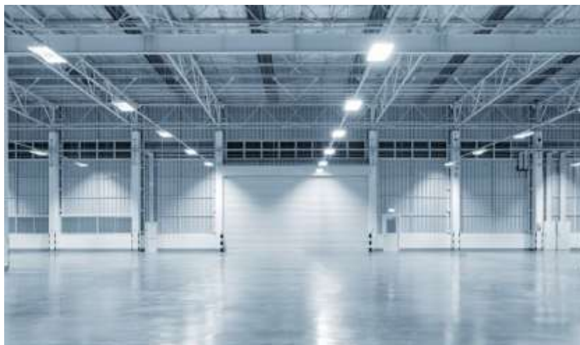
Figura 2. Nave industrial con la cubierta formada por celosías [4].
