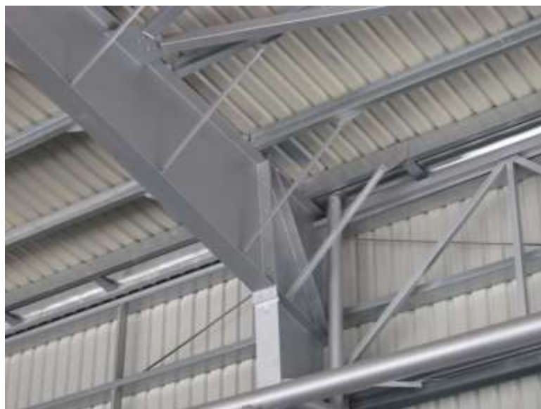
Figura 51. Ejemplo de disposición de tornapuntas entre las correas y el dintel [17].
