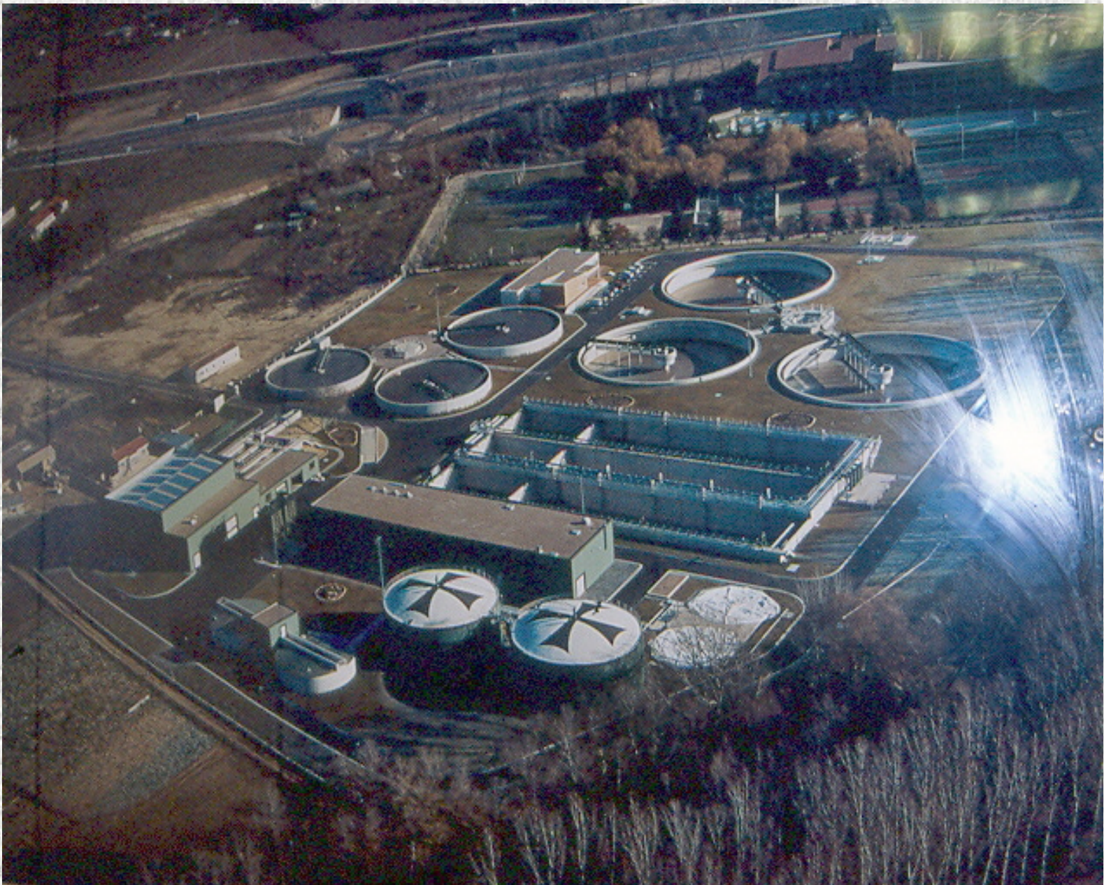
Estación EDAR de Palencia
