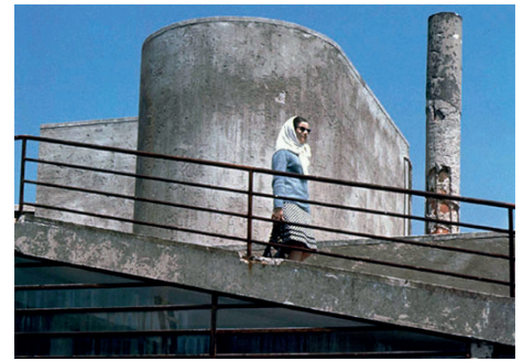
Figura 31. Chimenea junto al solárium de la Villa Savoye . FLC. Fondo fotográfico Felix Thyès, 1966, nº 5.
