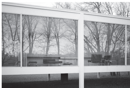
Figura 21. Columna de instalaciones bajo la Casa Farnsworth (1945-51), Mies. Fuente: Wikimedia Commons.
