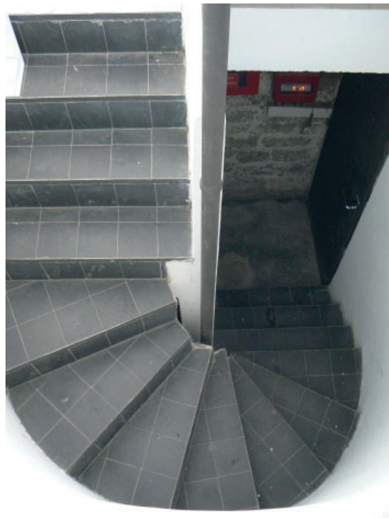
Figura 28. Tramo de la escalera desde el sótano de la Villa Savoye . Fotografía de Jorge Ramos.
