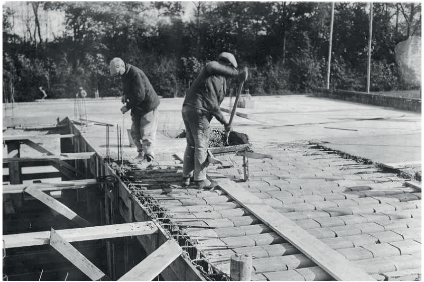
Figura 28. Fotografía del forjado de techo de planta baja de la Villa Savoye , mirando hacia el sur, ¿Sert o Norman Rice?, 14-5-1929. FLC L2 (17) 203.
