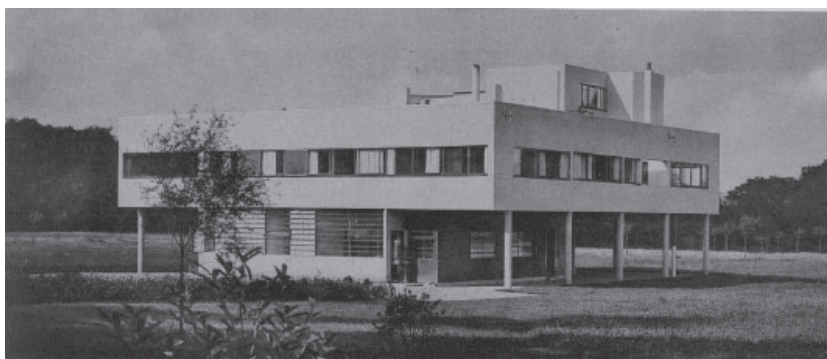
Figura 30. Fotografía de la fachada sureste de la Villa Savoye , en noviembre de 1930. Marius Grivot. L'Architecture Vivante , nº IX, 1931 (printemps-été), p. 27 (foto 1).
