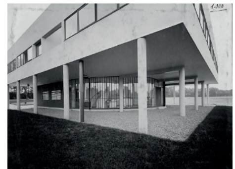
Figura 5. Fotografía de la esquina norte de la Villa Savoye en noviembre de 1930. Marius Gravot. FLC L2 (17) 022.
