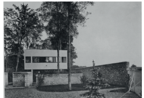
Figura 3. El uso de la mampostería en el pabellón de entrada de la Villa Savoye , en noviembre de 1930. Fotografía de Marius Grivot. FLC L2 (17) 001.
