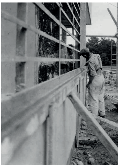
Figura 23. Fotografía de los trabajos de enlosado del pesebrón en la fachada sureste de la planta baja de la Villa Savoye, en septiembre de 1929. FLC L2 (17) 198.
