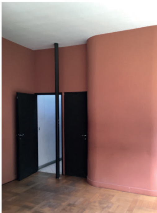
Figura 28. Conducto en el dormitorio del hijo en planta primera en la Villa Savoye . Fotografía del autor.
