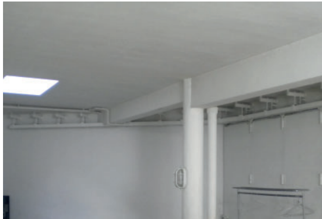
Figura 52. Cambios de canto y sección en la viga del techo del garaje de la Villa Savoye. Fotografía del autor
