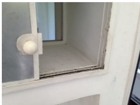
Figura 13. Puertas correderas de los armarios de la cocina de la Villa Savoye . Fotografía del autor.
