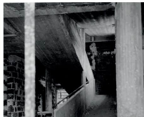
Figura 3. Fotografía de las obras de tabiquería del arranque de la rampa de la Villa Savoye en septiembre de 1929. FLC L2 (17) 197.
