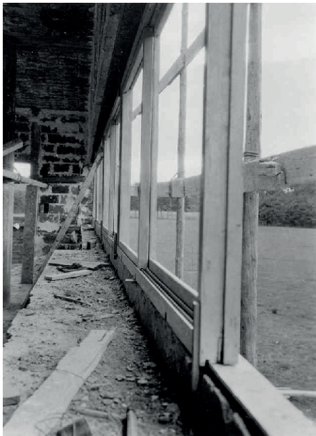
Figura 61. Fotografía de obra del dintel de la ventana del salón de la Villa Savoye en septiembre de 1929. FLC L2 (17) 199.
