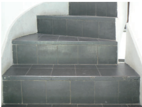
Figura 17. Despiece de plaquetas en la escalera de la Villa Savoye. Fotografía de Jorge Ramos.
