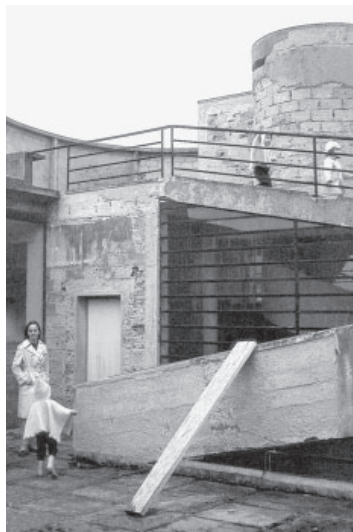
Figura 15. Los pilares del descansillo de la rampa de la Villa Savoye, 1965. FLC Fondo fotográfico Terseur, nº 26. El hormigón del peto de la rampa, c1967. FLC, fotografía de autor desconocido.
