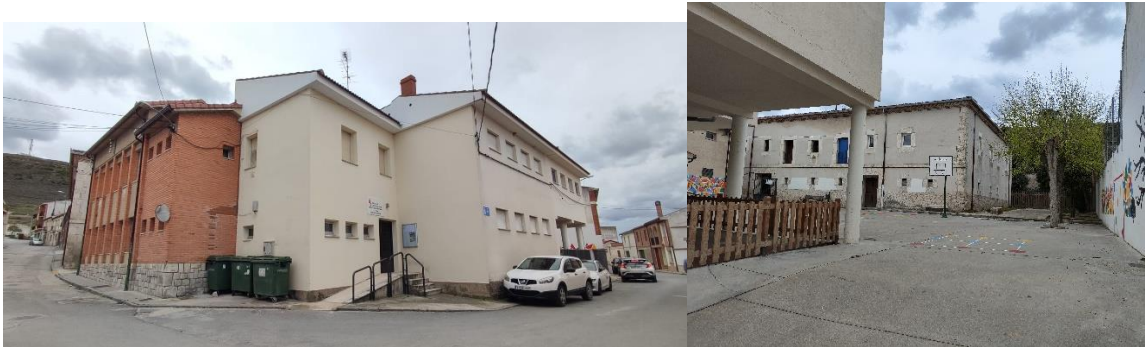
Chañe. Colegio y polideportivo municipal por el exterior.
