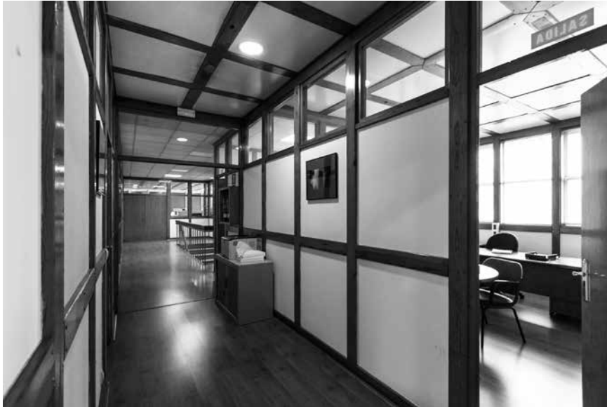
Fig. 16 Edificio de oficinas . Modulación interior con elementos en madera de pino.
