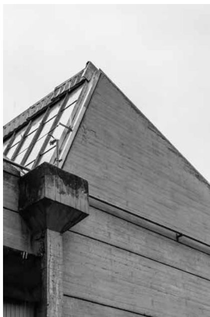
Fig. 5 Nave de Tableros Especiales . Fotografía de los dientes de la cubierta y detalle del canalón.
