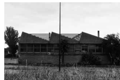
Fig. 7 Nave de Tableros Aislantes. Fotografía de la fachada oeste (desde Ctra. Overuela)
