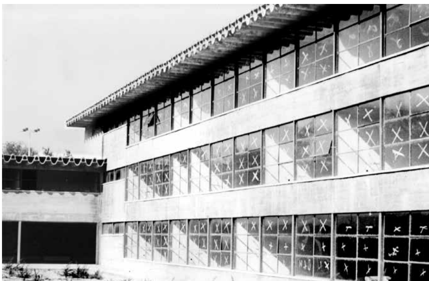
Fig. 11 Instituto Núñez de Arce en construcción. Bloque de aulas.
