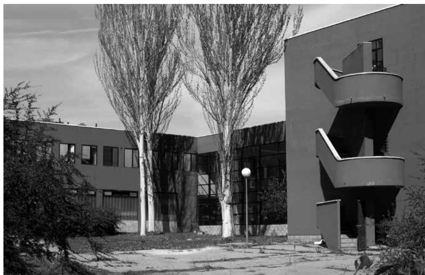
Fig. 35 A. Casares Ávila y R. de Aburto, Centro de Salud en Polígono "Arturo Eyries" (Valladolid, 1980-1985).
