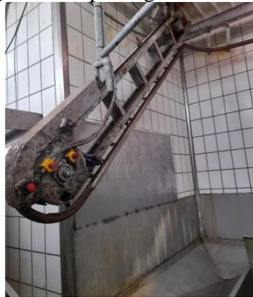
Fig. 17. Tolva de desangrado y cadena de elevación. [11]
