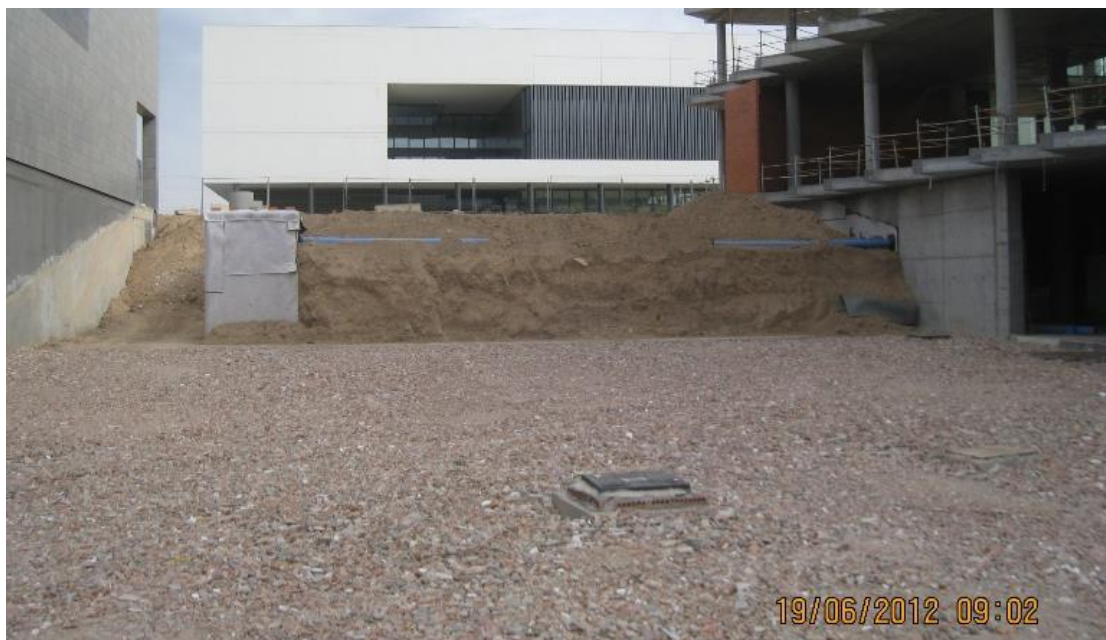
Ilustración 27. Instalación tubos geotérmicos enterrados. Fase construcción.
