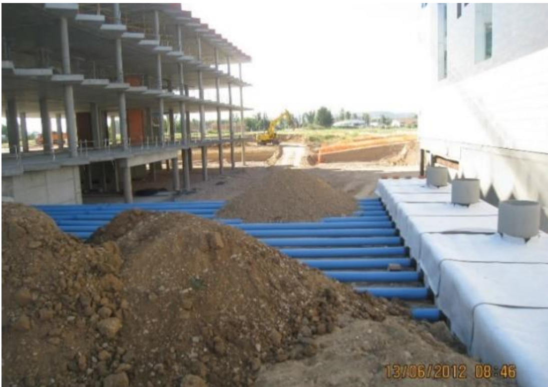
Ilustración 29. Toma de aire sistema de geotermia. Fase construcción.
