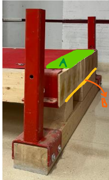
Figura 33. Detalle superficies de apoyos plataforma
