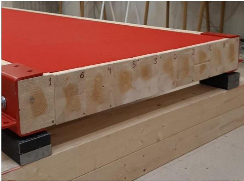
Figura 66. Colocación vigas en la antigua plataforma
