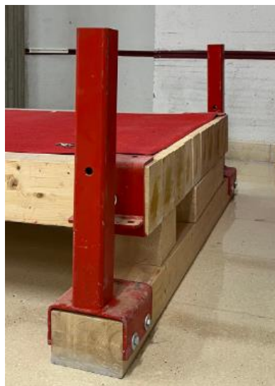
Figura 11. Detalle apoyo de la plataforma
