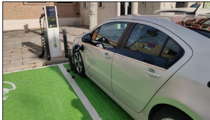
Ilustración 35. Poste eléctrico Calle de la Ribera, 10 (Aranda de Duero). Fuente: Electromaps
