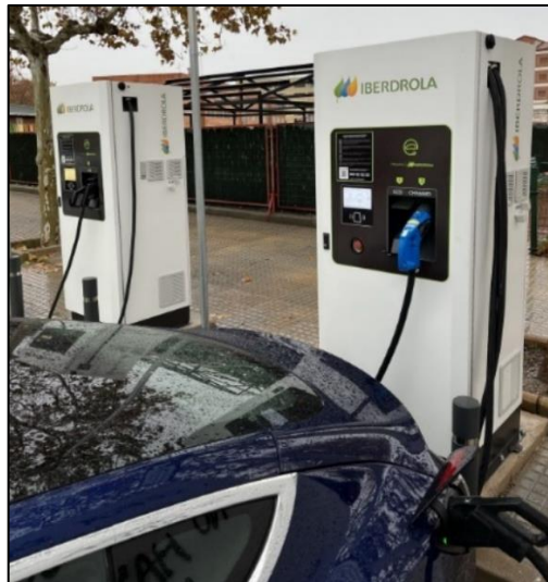
Ilustración 37. Postes eléctricos Calle de la Hispanidad 0 (Aranda de Duero). Fuente: Electromaps
