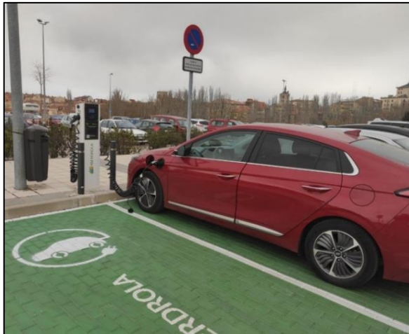
Ilustración 34. Poste eléctrico Calle Quinta Julia, 31 (Aranda de Duero). Fuente: Electromaps
