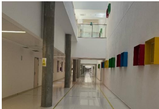
Figura 2. Pasillo interior del HURH
