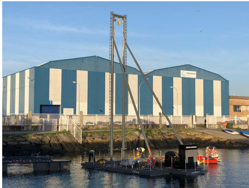
Ilustración 37. Hinca de pilotes. (Lindley, 2024)
