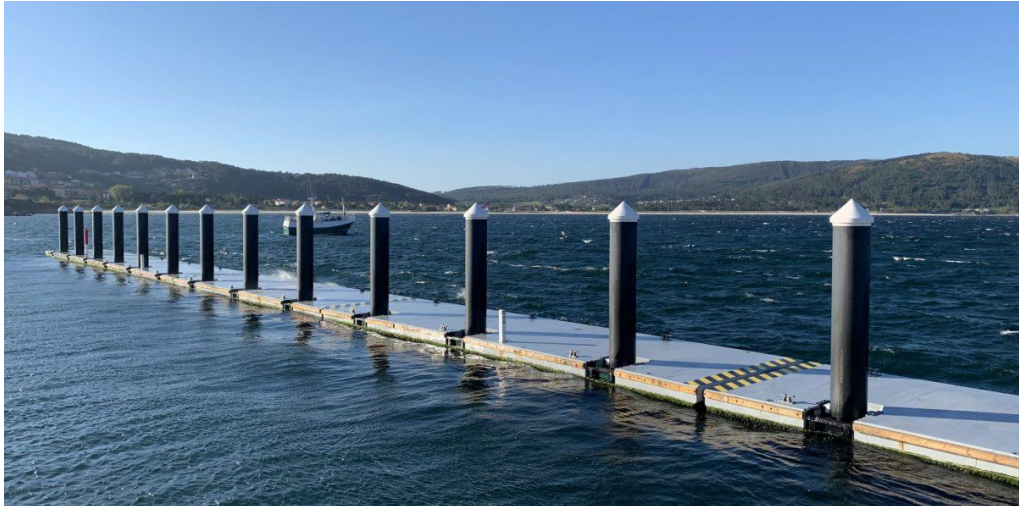
Ilustración 6. Pantalán de bloques. (Ad Hoc Smart Solution, 2022)
