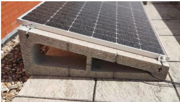
Imagen 11. Foto de la fijación triangular de hormigón en la cubierta 14
