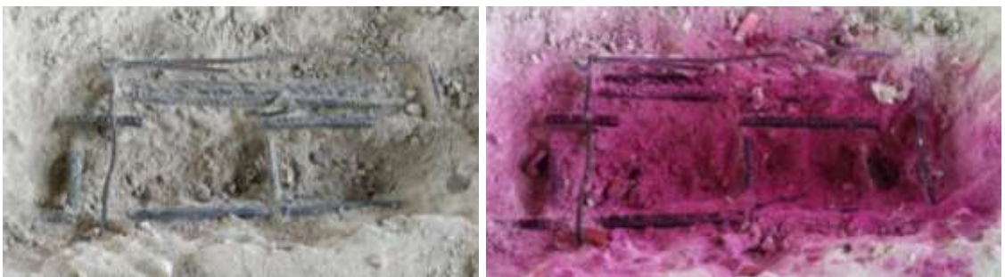
Figura A8. CATA 4. Antes y después del ensayo
