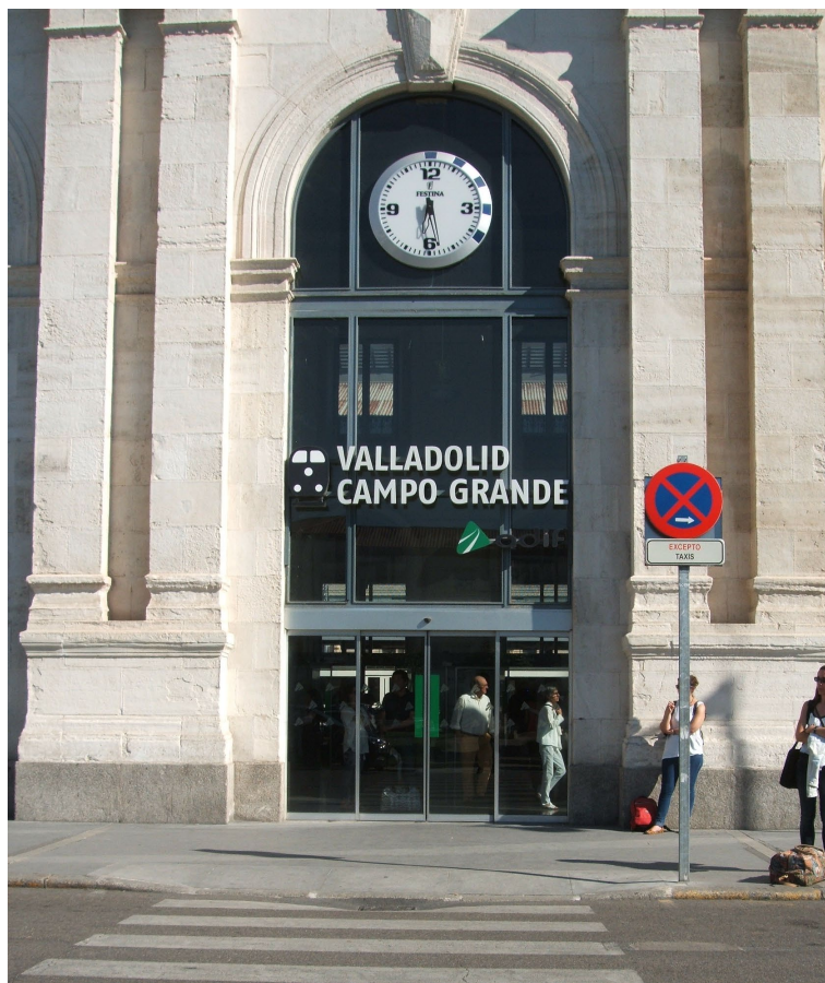
Figura 4.38.- Contraste cromático puerta-fachada en Estación “Valladolid – Campo Grande”
