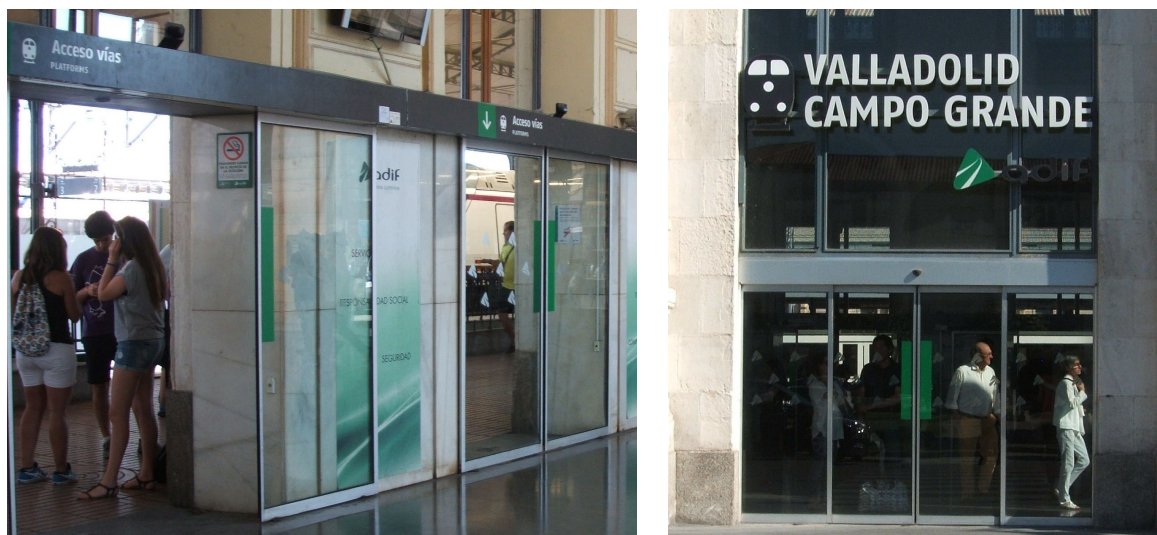
Figura 4.28.- Puertas automáticas con célula fotoeléctrica en Estación “Valladolid – Campo Grande”
