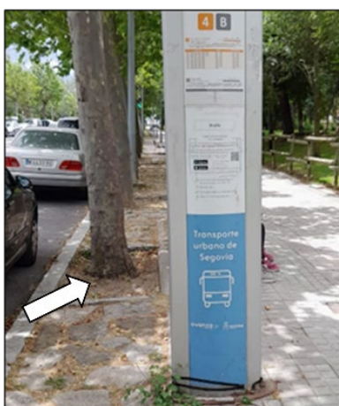
Figura 6.14.- Parada de autobús con alcorques no enrasados al pavimento, Segovia
