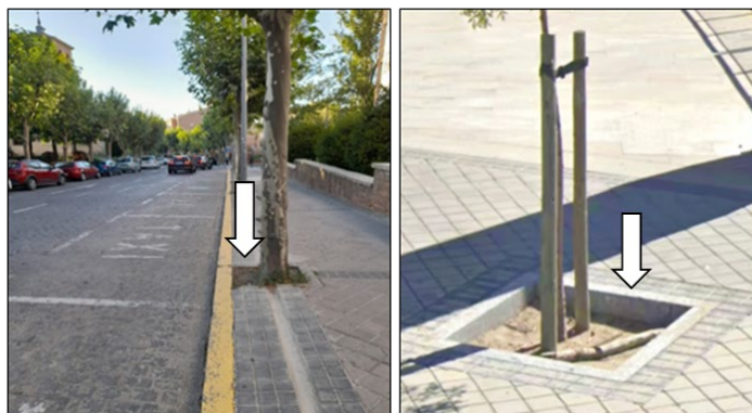
Figura 6.22.- Alcorques no enrasados próximos a Paradas de Taxi, Segovia
