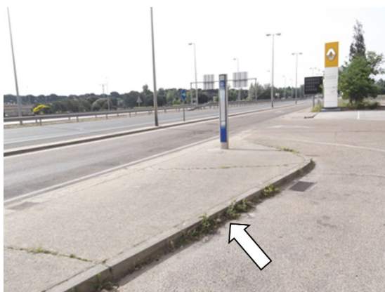
Figura 5.4.- Desnivel no salvado por rampa, Valladolid
