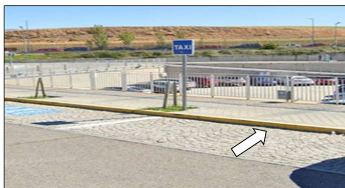
Figura 6.18.- Desnivel no salvado por rampa en acceso a parada de Taxi, Segovia
