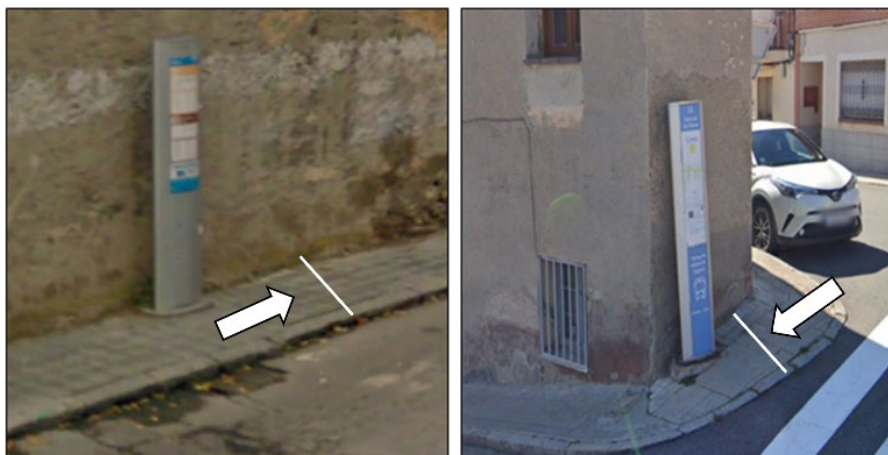
Figura 6.9.- Paradas con ancho de acera inferior a 1.50 metros, Segovia
