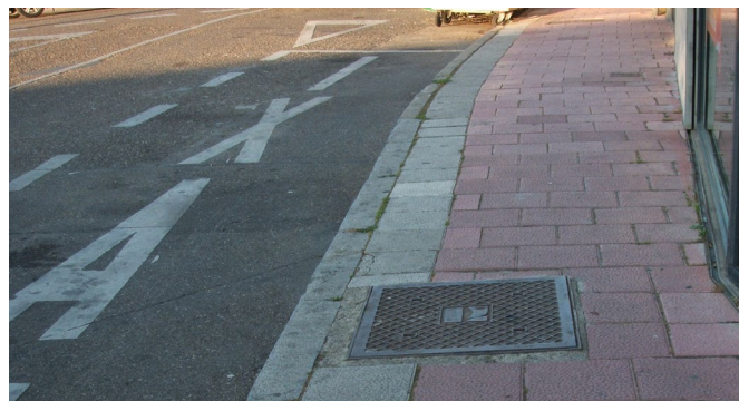
Figura 5.17.- Parada de taxi con anchura inferior a 1,50 metros, Valladolid
