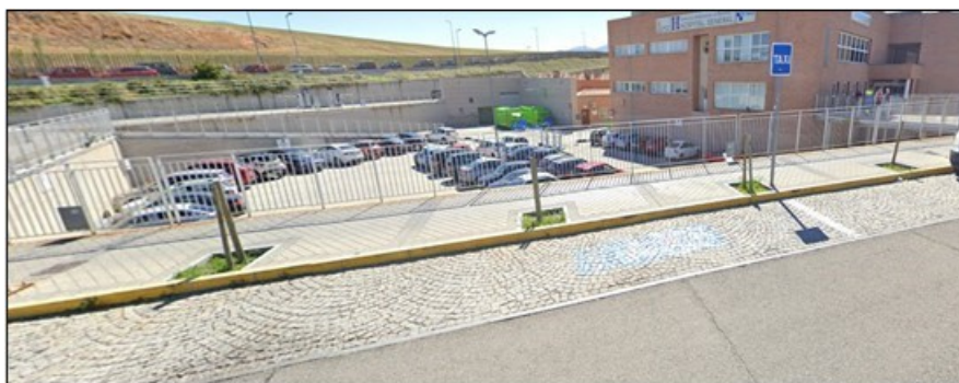
Figura 6.21.- Parada de Taxi sin rampa de acceso, Segovia
