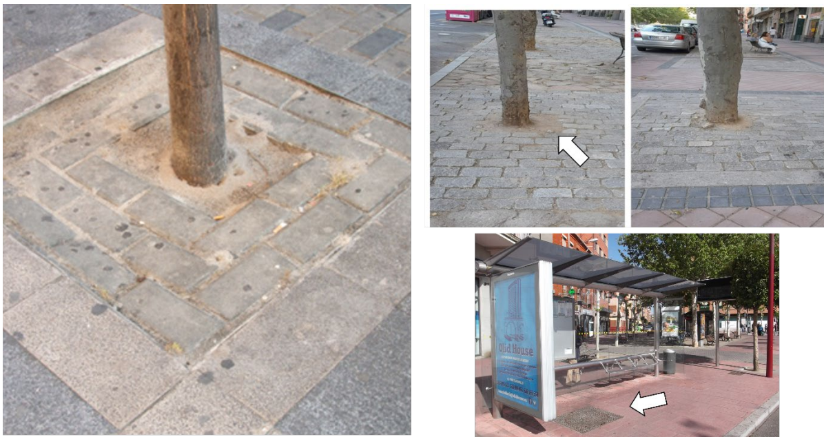
Figura 4.17.- Alcorques y tapas de registro enrasados con el pavimento
