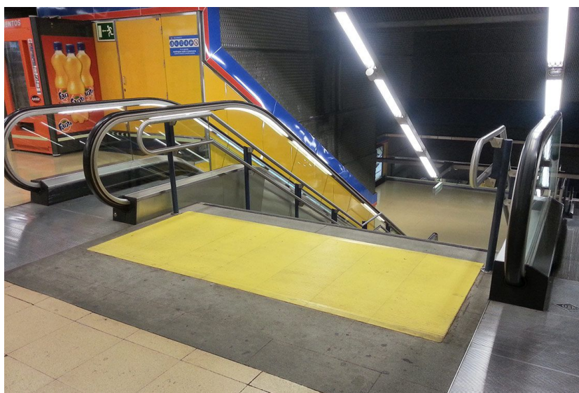
Figura 4.37.- Pavimento en arranque de escalera
