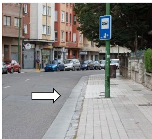
Figura 4.11.- Parada invadiendo carril de circulación
