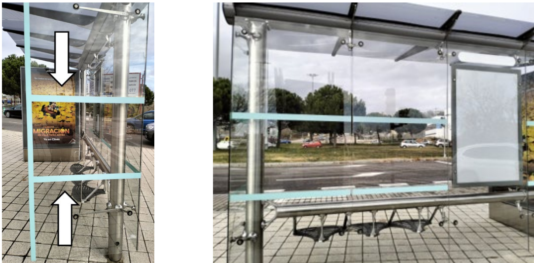
Figura 4.13.- Señalización cerramiento transparente de marquesina con bandas horizontales
