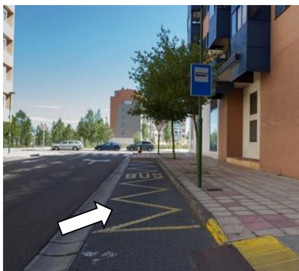
Figura 4.10.- Carril habilitado para parada de autobús
