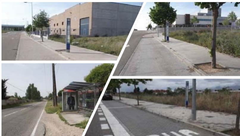
Figura 5.8.- Paradas con vados o rebajes a más de 100 metros, Valladolid
