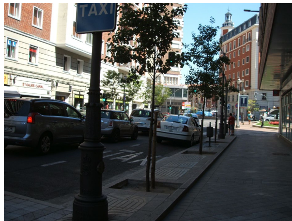
Figura 5.15.- Escalón no salvado por rampa en acceso a parada de taxi, Valladolid
