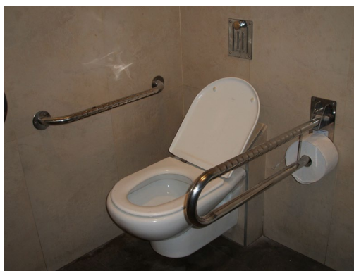
Figura 4.32.- Barras de apoyo en servicio adaptado
