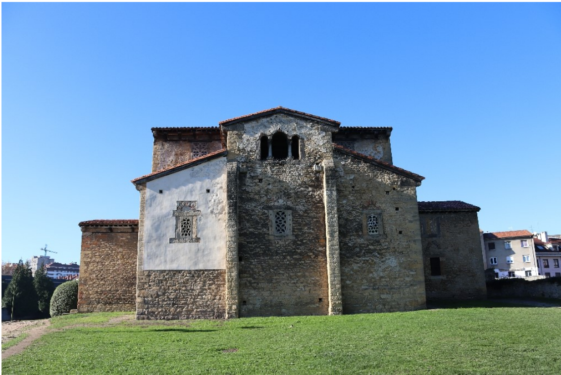
Ilus. 93. Vista oriental de la iglesia, donde se aprecia el triple ábside y la habitación comunicada sobre el altar principal.
