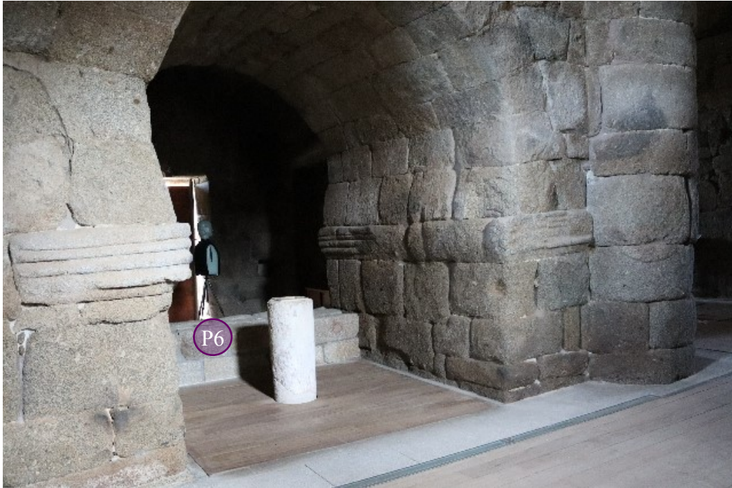
Ilus. 254. HATS ubicado en P6, en el interior del ábside lateral norte en SMM.
