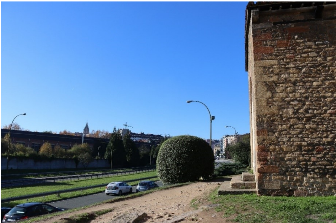
Ilus. 88. Vista del lado sur de San Julián, con la carretera que transcurre en sus proximidades.
