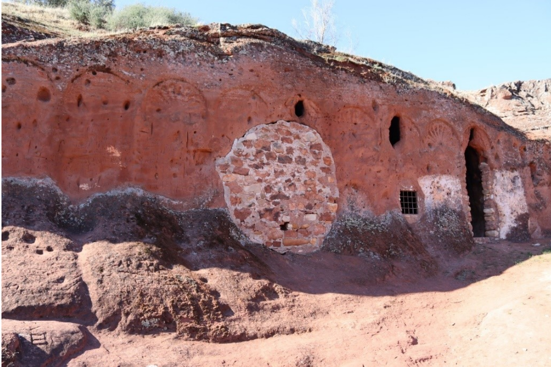
Ilus. 48. Vista de la fachada del eremitorio rupestre de Valdecañales.
