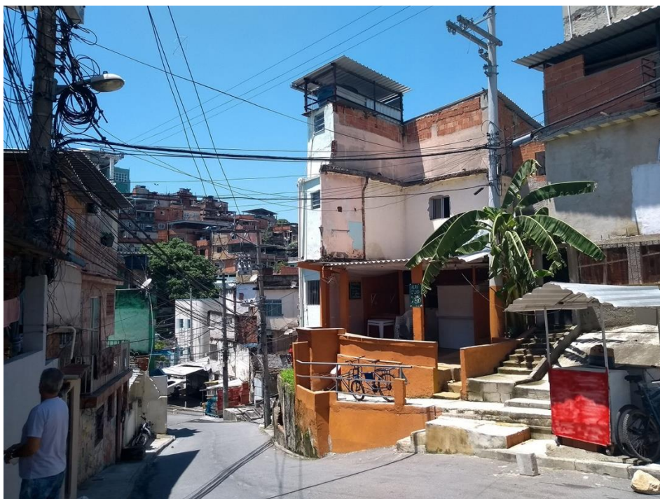
Figura 10: Em 2019, o bar construído pelo morador entrevistado e, ao lado, uma escada de novo acesso a moradias que, antes, davam fundos à Av. Central. Fonte: Elaboração própria.
