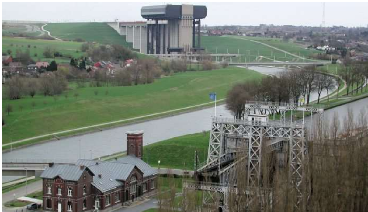
Figure 59 : Nuevo ascensor al fondo y ascensor histórico (Fuente: Office du tourisme du Roelux ,2024)
