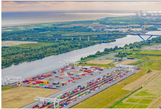
Figure 7: Plataforma multimodal en el puerto de Le Havre (Fuente: haropaport,2024)
