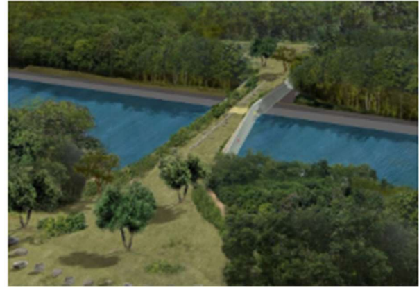
Figure 33 : Paso de fauna(Fuente: CNSE,2024)
