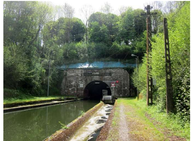
Figure 23: entrada al paso subterráneo de Riqueval.( Fuente: Wikipedia,2024)
