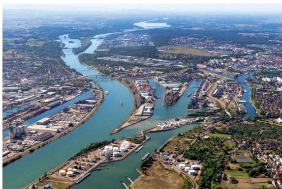
Figure 10 :Vista aérea de los distintos muelles de descarga (Fuente:Strasbourg port ,2024)
