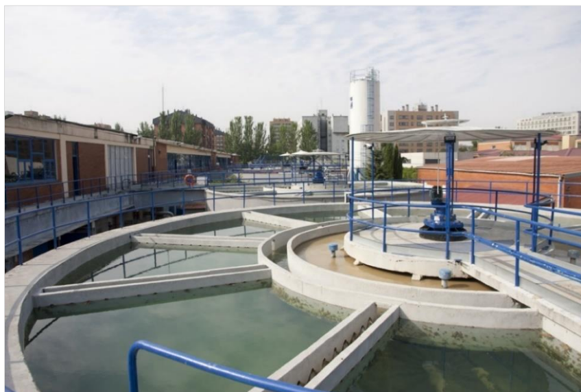
Figura 1. Estación Depuradora de Aguas Residuales de Valladolid. Fuente: Aquavall
