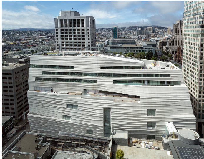
Fig. 19. SFMOMA, San Francisco Fuente: https://goo.su/GG0iQKW
