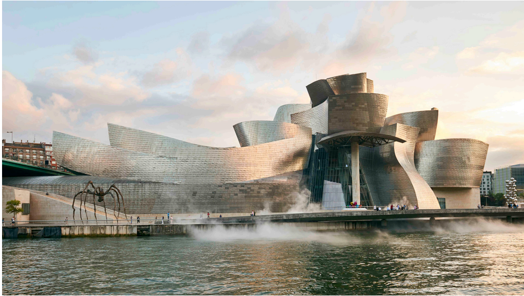
Fig. 22. Museo Guggenheim Bilbao y su entorno Fuente: https://www.guggenheim-bilbao.eus/el-edificio
