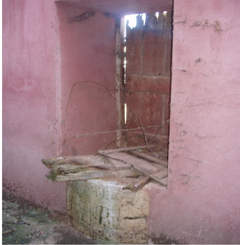
Pozo común en la pared divisoria no original Entre el testero del Teatro Latorre y la Plaza de Toros
