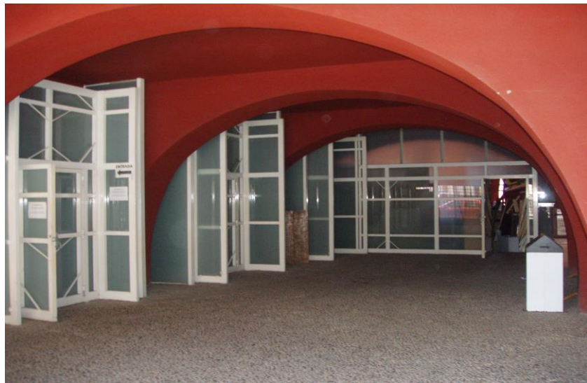
Entrada común al Teatro Latorre y al antiguo Salón de Bailes, que será reformada para ubicar allí servicios comunes y acceso a la Plaza de Toros
