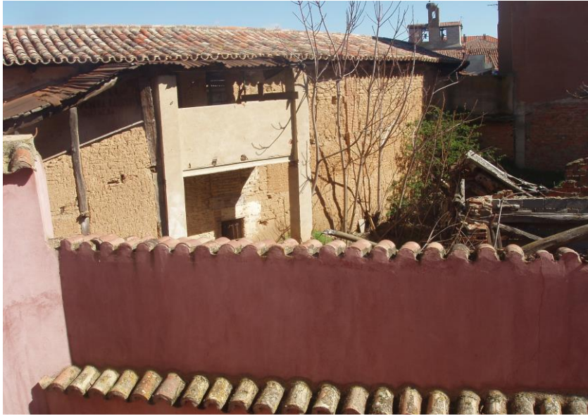
Vista desde el Local de Ensayos, donde ha de ser realizado un balcón hacia la Plaza de Toros, y de la tapia divisoria no original que será derribada
