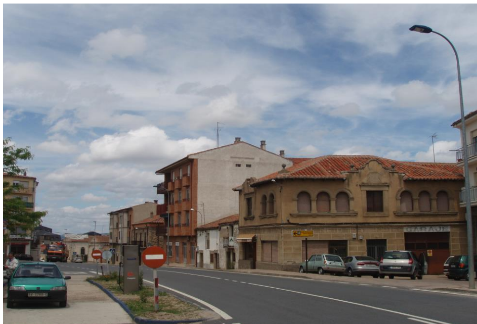
Edificios de la manzana 29238 que dan a la línea noreste de la muralla
