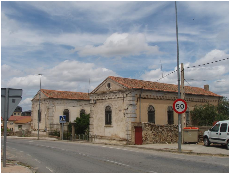
Edificio de la parcela 27240. Antigua fábrica textil
