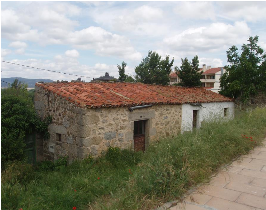
Vista de la manzana 28202 con una serie de antiguas edificaciones
