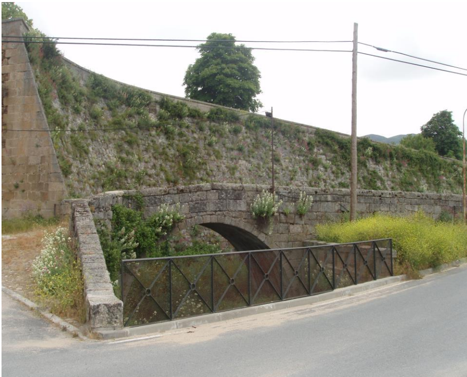
Puente de El Barco
