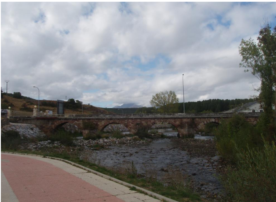
Puente de San Roque con una parte de la ribera derecha del río Pisuerga
