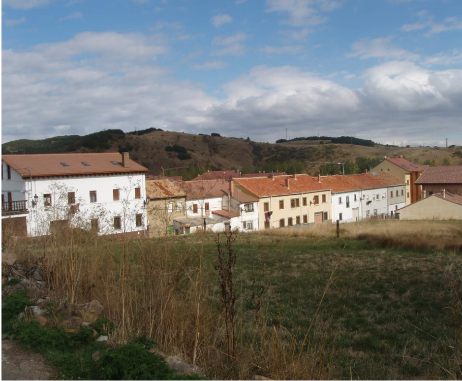
Cierre visual del caserío de Cervera entre la calle de la Dehesa y el Paseo Mónica Plaza
