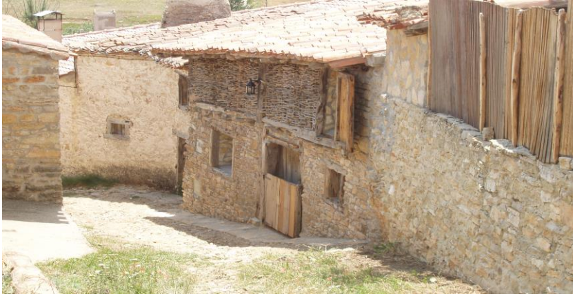
Ejemplo de rehabilitación adecuada de una de las viviendas de La Cuenca
