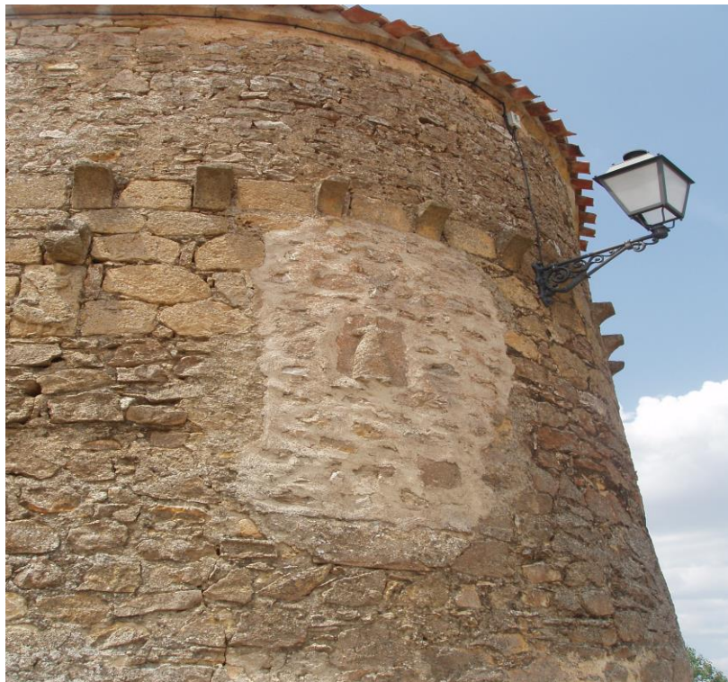
Ábside de la Iglesia con relieve empotrado
