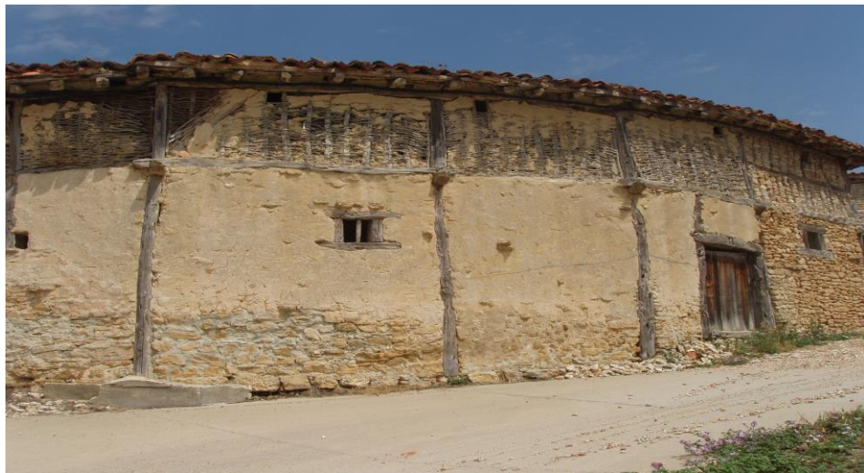
Muros de mampostería de caliza y encastados típicos de la arquitectura de La Cuenca
