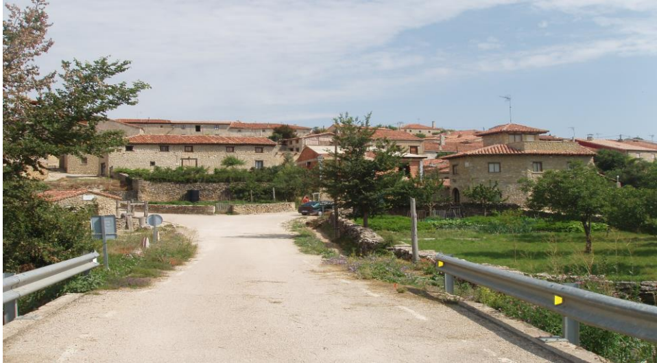
Vista de la entrada a la localidad de La Cuenca, con el puente sobre el río Abión, el caserío y la vegetación de ribera y prados
