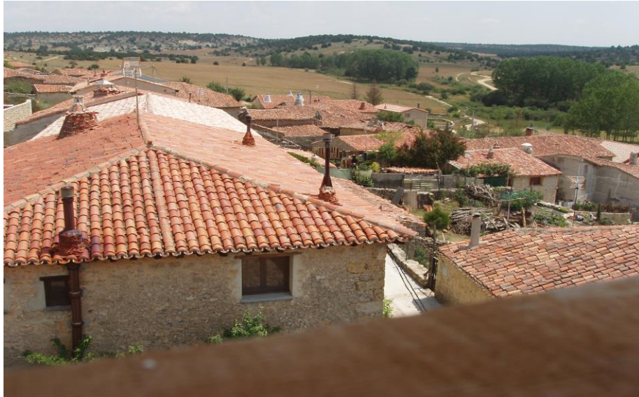
Nuevos tejados de viviendas de La Cuenca ajenos a La arquitectura tradicional
