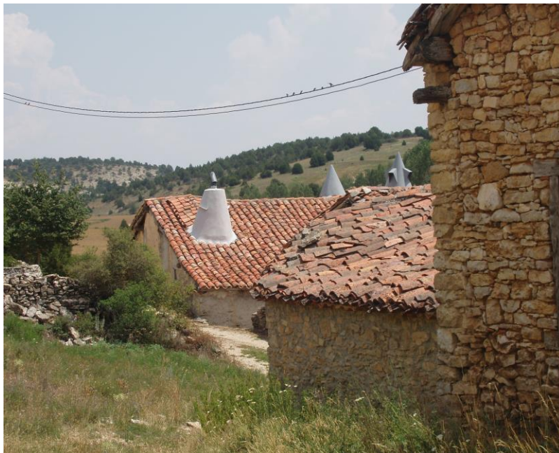
Chimeneas rehabilitadas de La Cuenca ajenas a materiales tradicionales
