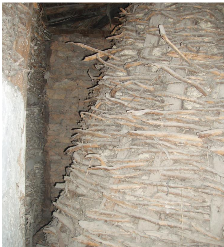
Encestado de la chimenea de la cocina de la vivienda anterior
