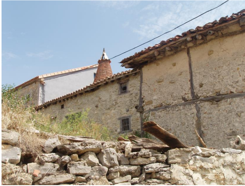
Entramados rellenos de adobe y chimenea pinariega de una casa de La Cuenca
