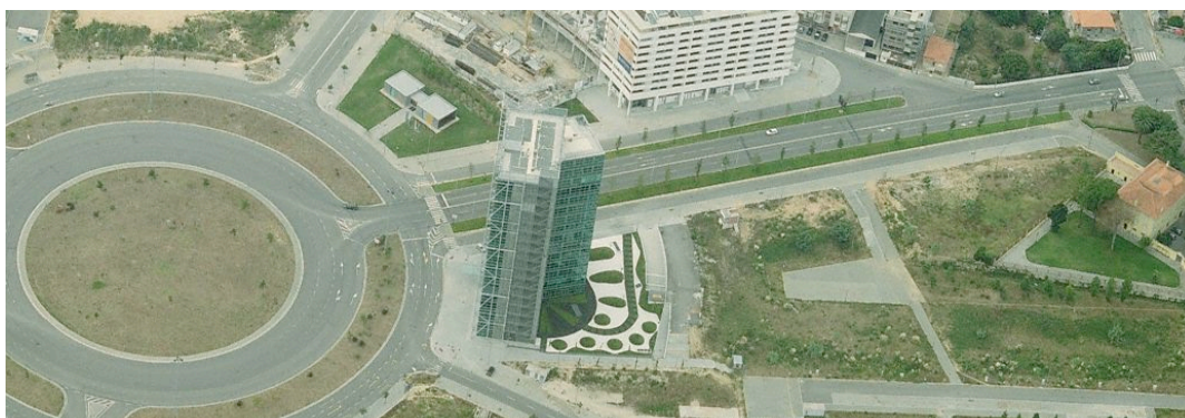
Figura 29 – Vista aérea tridimensional da V8 com as vias laterais executadas e a rotunda das Devesas em destaque | Fonte: Bing Maps
