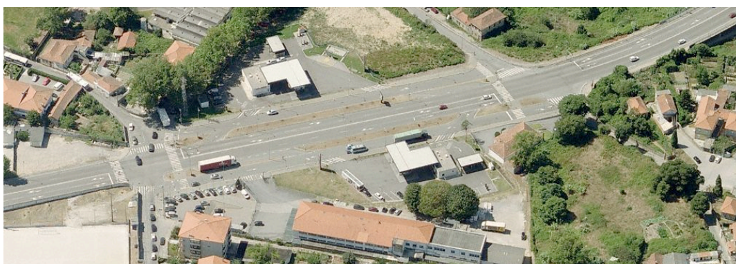
Figura 30 – Vista aérea tridimensional da V8 com as vias laterais executadas à face dos postos de abastecimento de combustível | Fonte: Bing Maps
