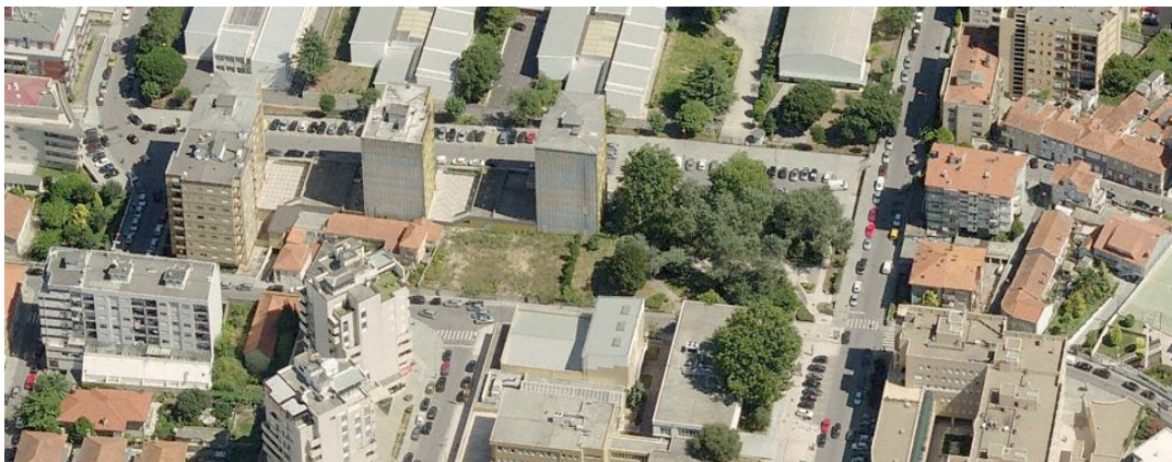
Figura 17 – Vista aérea tridimensional do local com orientação Poente/Nascente | Fonte: Bing Maps
