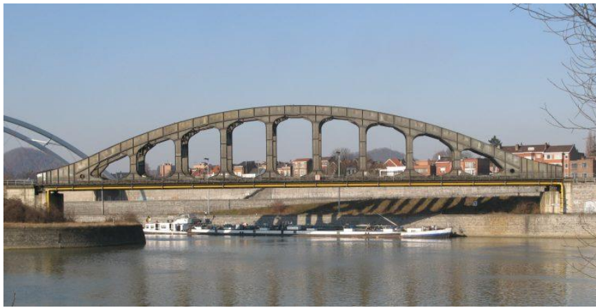
Figura 26. Puente Hafele vu Léč con forma de viga Vierendeel. [43]
