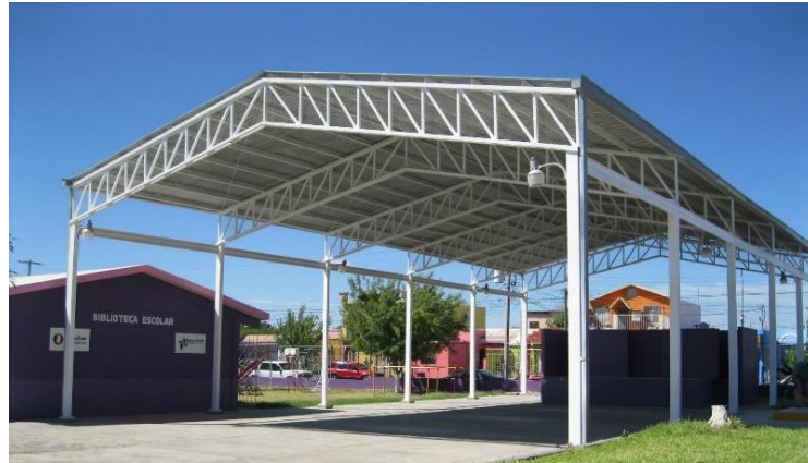
Figura 22. Viga en celosía en una nave industrial. [38]
