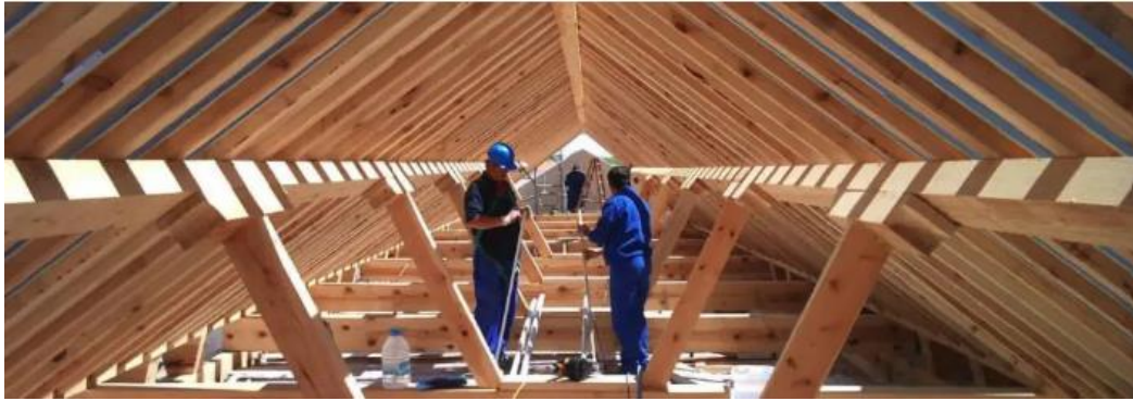
Figura 16. Uso estructural de la madera de pino silvestre. [29]
