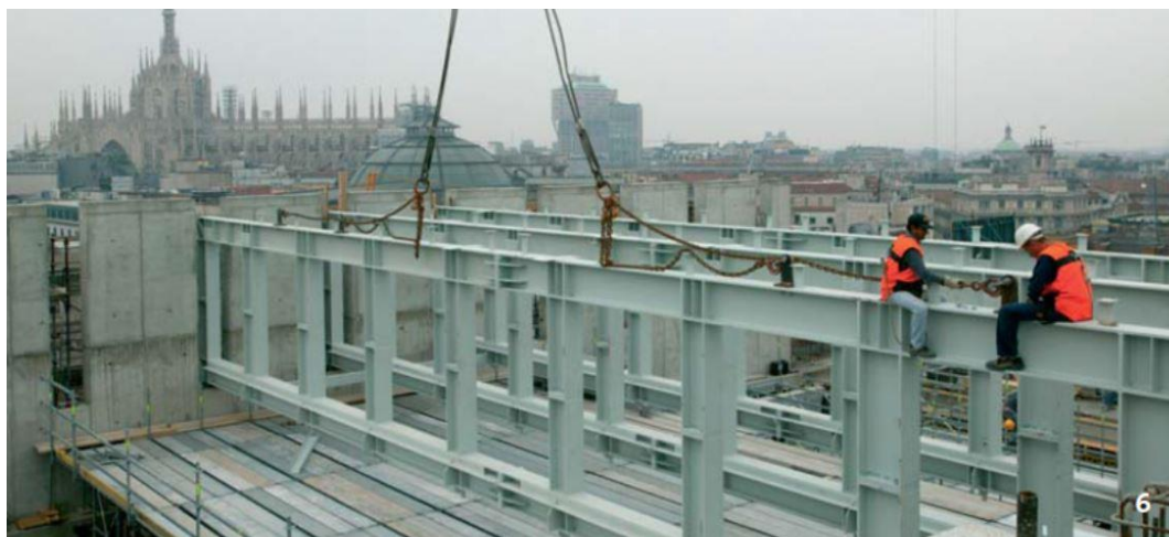
Figura 27. Vigas Vierendeel en el teatro Alla Scala de Milán. [44]
