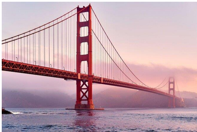
Figura 1.3: Vigas y puentes. Golden Gate [16]
