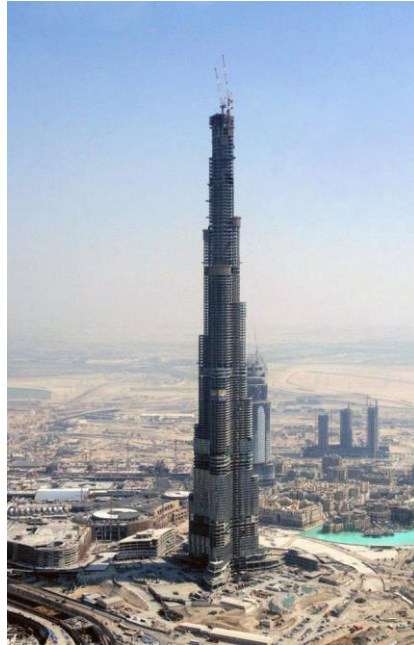
Figura 1.2: Pandeo en edificios. Burj Khalifa [26]
