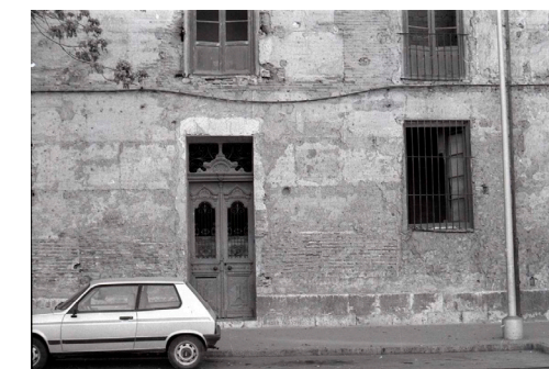
Fig. 56. Entrada secundaria del alzado norte de la Audiencia Territorial de Valladolid, segunda mitad del S. XX. Obtenida de https://archivomunicipalvalladolid.es/
