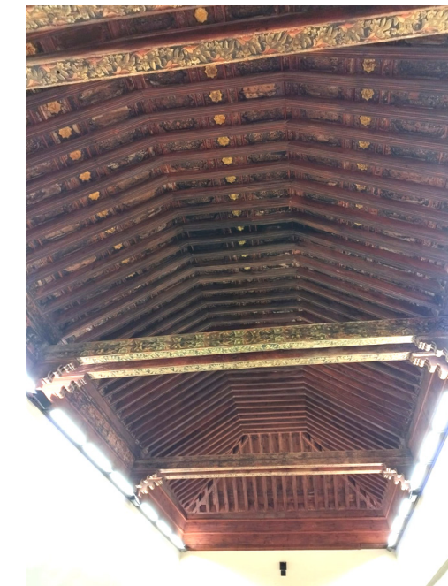
Fig. 29. Artesonado actual de la antigua Sala Rica del palacio de los Vivero y posterior Chancillería. Fotografía del autor.
