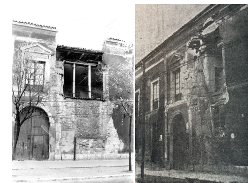
Fig. 59. Derrumbe parcial de la fachada de la Audiencia Territorial de Valladolid a finales del siglo XX. Obtenidas de https://archivomunicipalvalladolid.es/
