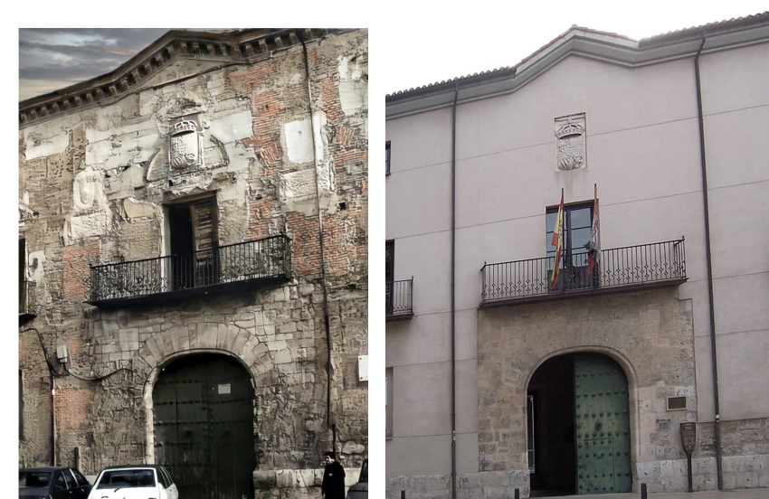
Fig. 60. Reforma exterior en la fachada principal del Archivo Histórico Provincial de Valladolid. Obtenidas de https://www.diariodevalladolid.es y https://www.google.es/maps
