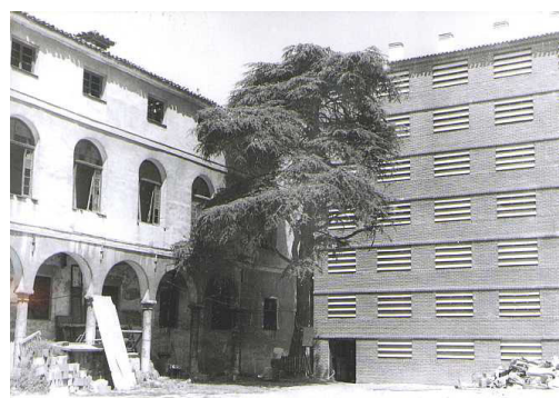
Fig. 81. Patio interior del Archivo de la Real Chancillería antes de su rehabilitación, en la década de 1970. Obtenido de https://archivomunicipalvalladolid.es
