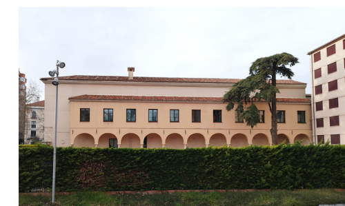
Fig. 69. Alzado sur del Archivo Histórico Provincial de Valladolid, y parte del nuevo edificio de Archivo de la Chancillería, 2024. Fotografía del autor.
