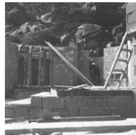
26. Casa Rotonda en construcción
