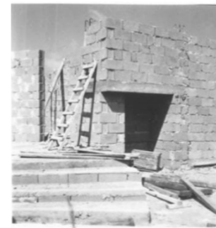
25. Casa Rotonda en construcción
