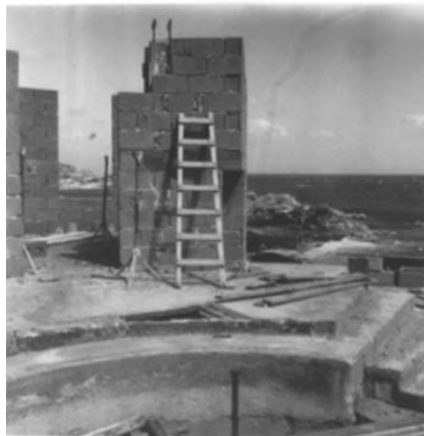
23. Casa Rotonda en construcción
