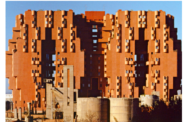
28. Fotografía del Walden 7
