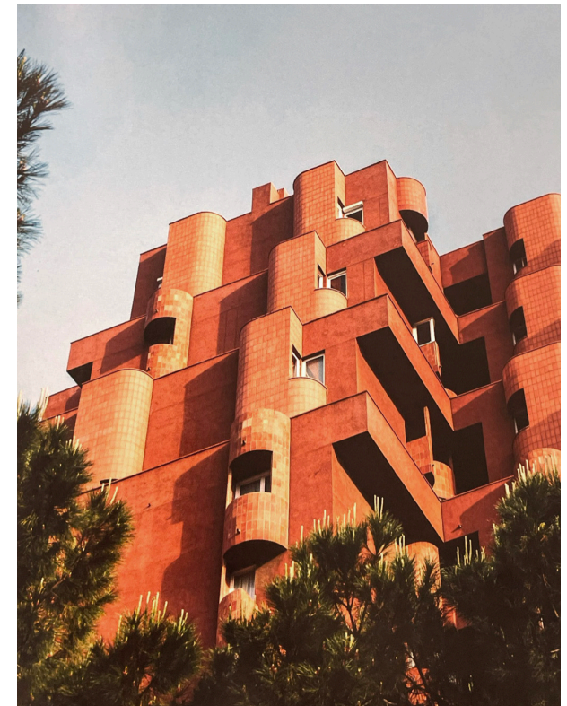
29. Fotografía del patio del Walden 7
