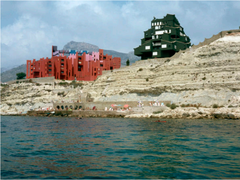
18. Imagen de la urbanización 'La Manzanera'
